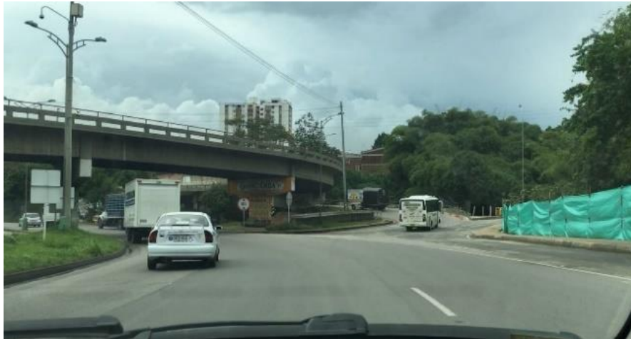
Figura 2. Perfil en curva con entrada y salida de vehículos.
