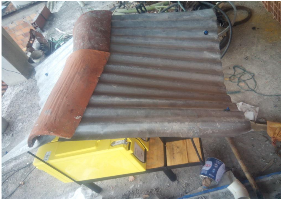
Figura 68. Techo del soporte de las baterías e inversor
