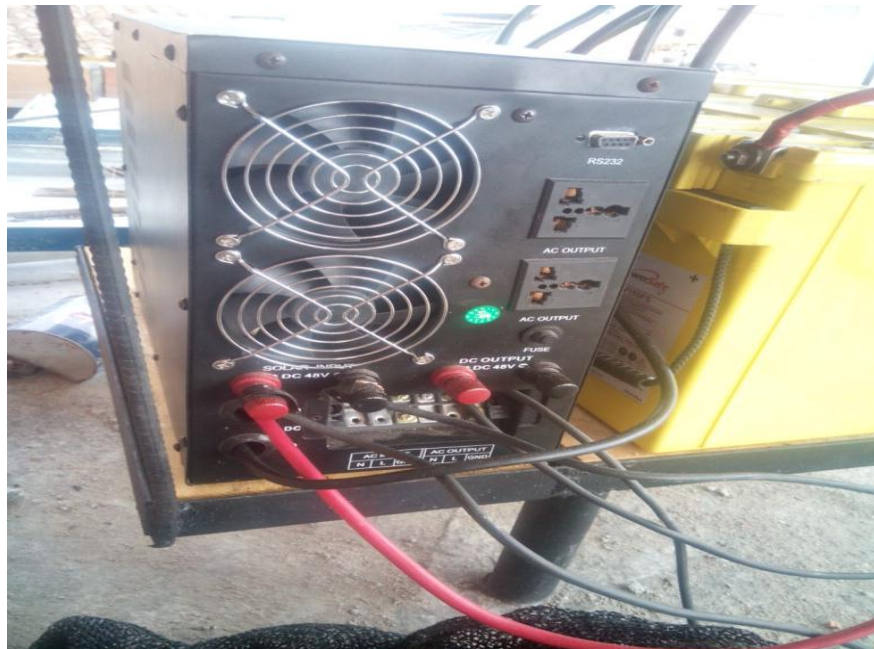
Figura 75. Conexiones del inversor parte trasera
