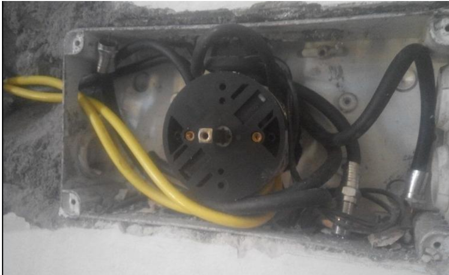
Figura 70. Transferencia conmutable de 3 posiciones
