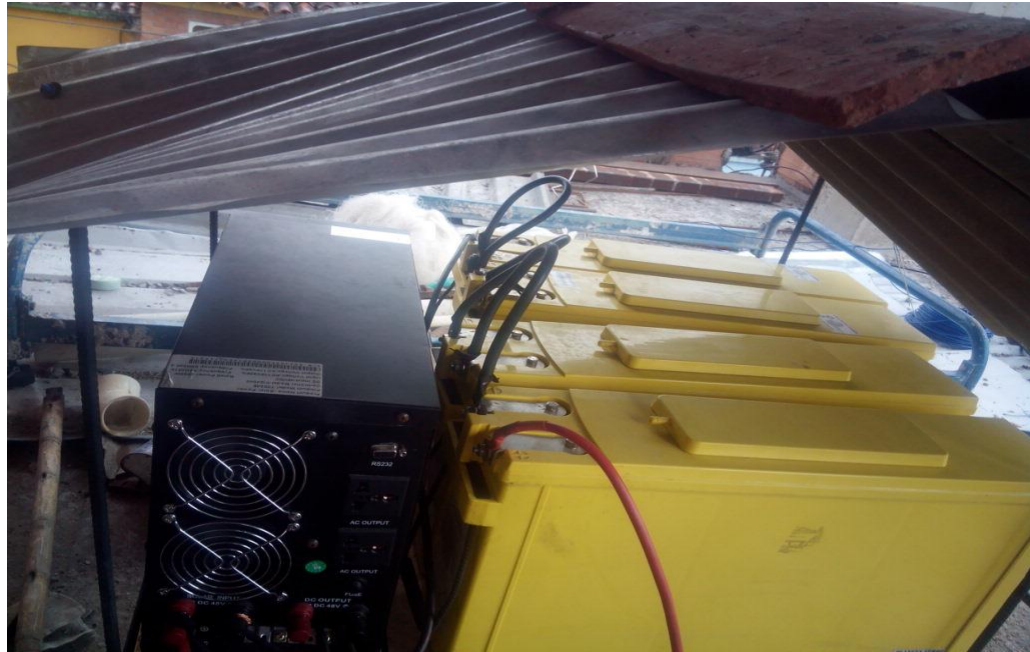
Figura 74. Conexiones de las baterías de gel
