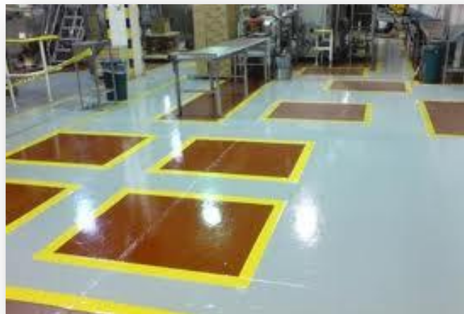
Figura 25. Identificación y señalización de los Pisos en las áreas de trabajo.
