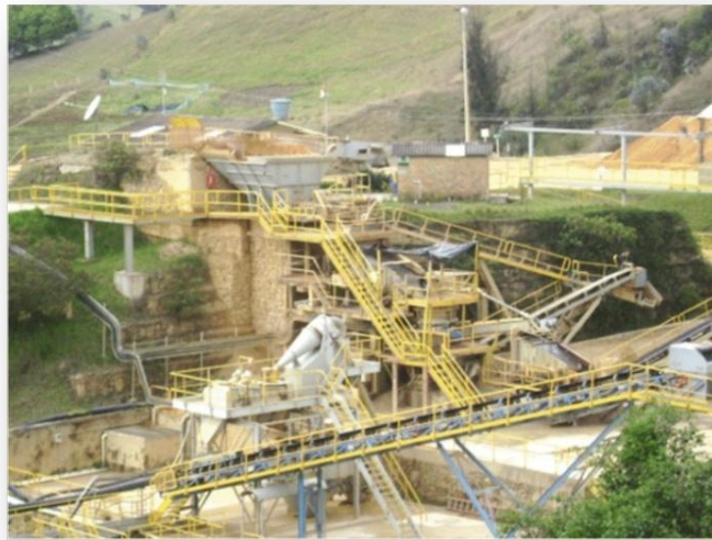
Figura 1. Ubicación geográfica Planta de agregados Chocontá. Ubicada en el municipio de Chocontá, Km. 65 vía Bogotá – Tunja.
