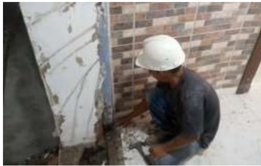
Figura 52. Estado de la bajante metálica.
