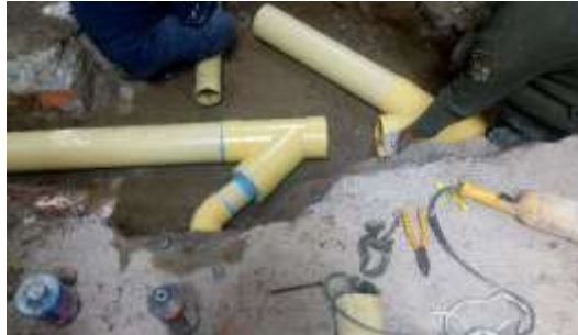
Figura 43. Instalación de tubería sanitaria
