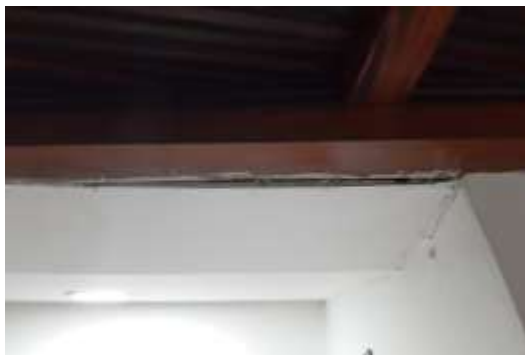
Figura 6. Pasillo interior de la casa cural
