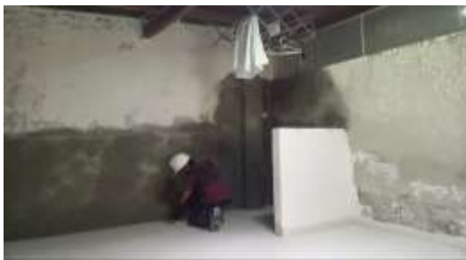
Figura 50. Resane e impermeabilización en muros.
