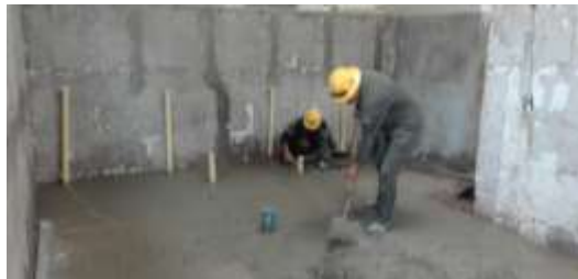
Figura 44. Fundición de losa de concreto
