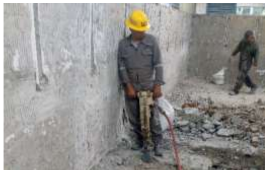
Figura 40. Uso de martillo de demolición.
