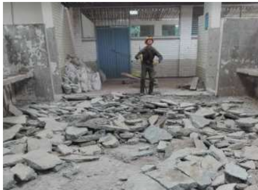
Figura 39. Demolición de losa en concreto.
