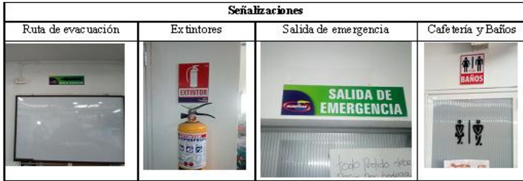
Figura 38. Señalizaciones en áreas de la empresa.
