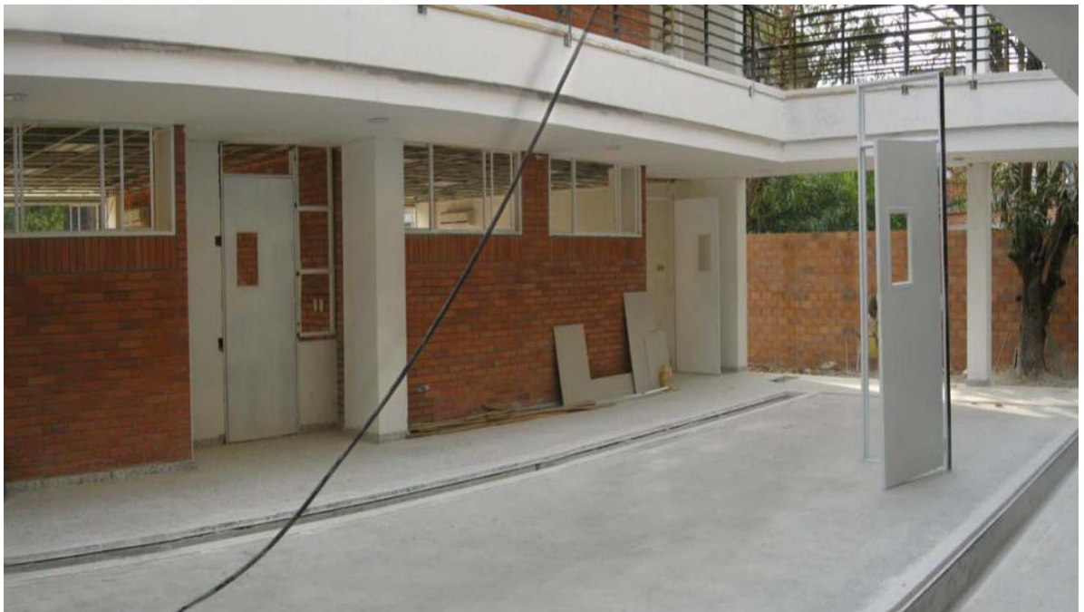
Fotografía N°3. Interior modulo B – pisos en granito pulido. Autor: Javier Mauricio Salazar Acevedo
