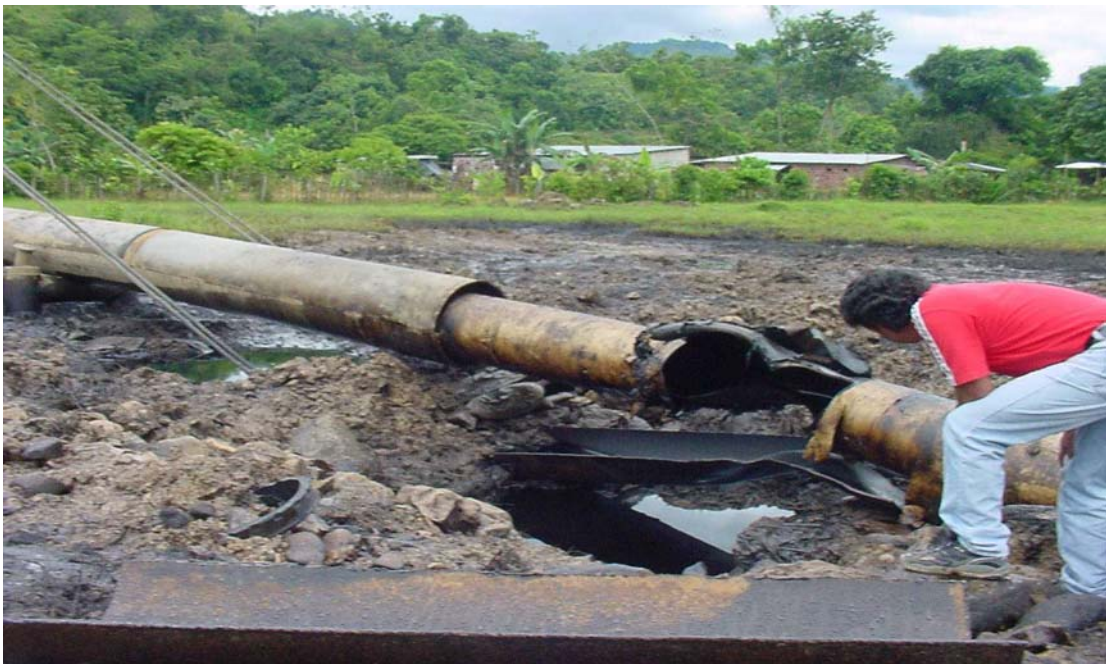
Foto 41. Reparación de tramo de oleoducto: La China – Samoré
