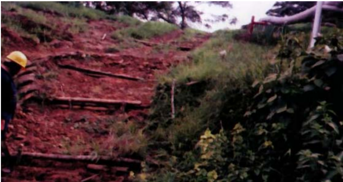
Foto 24. Construcción de barreras para control de erosión
