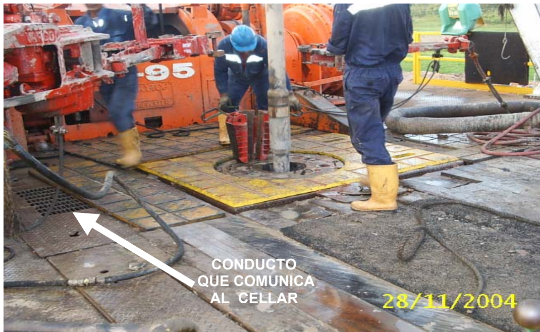
Figura 84: Plataforma de Perforación
