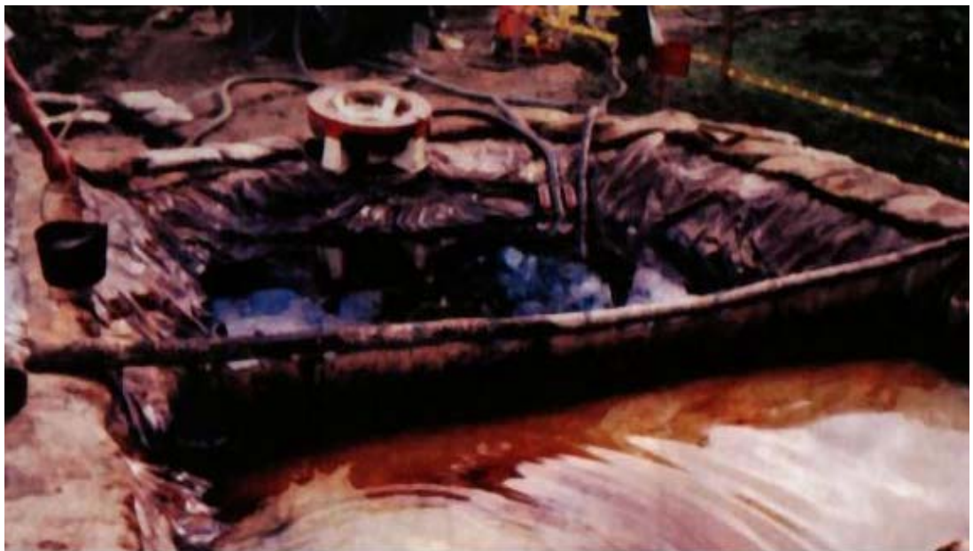
Foto 12. Adecuación de las piscinas para recuperación de aceite
