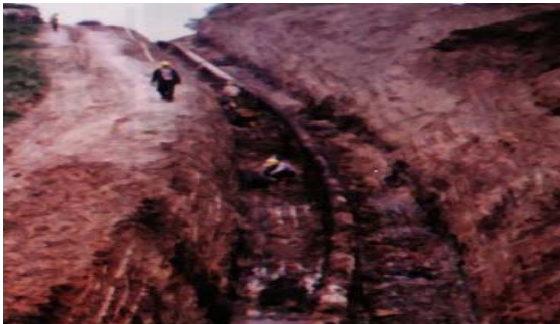
Foto 14. Reparación de oleoducto
