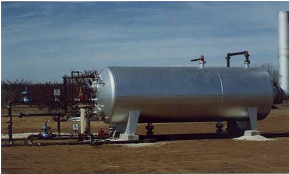
Figura 87: Separador Horizontal
