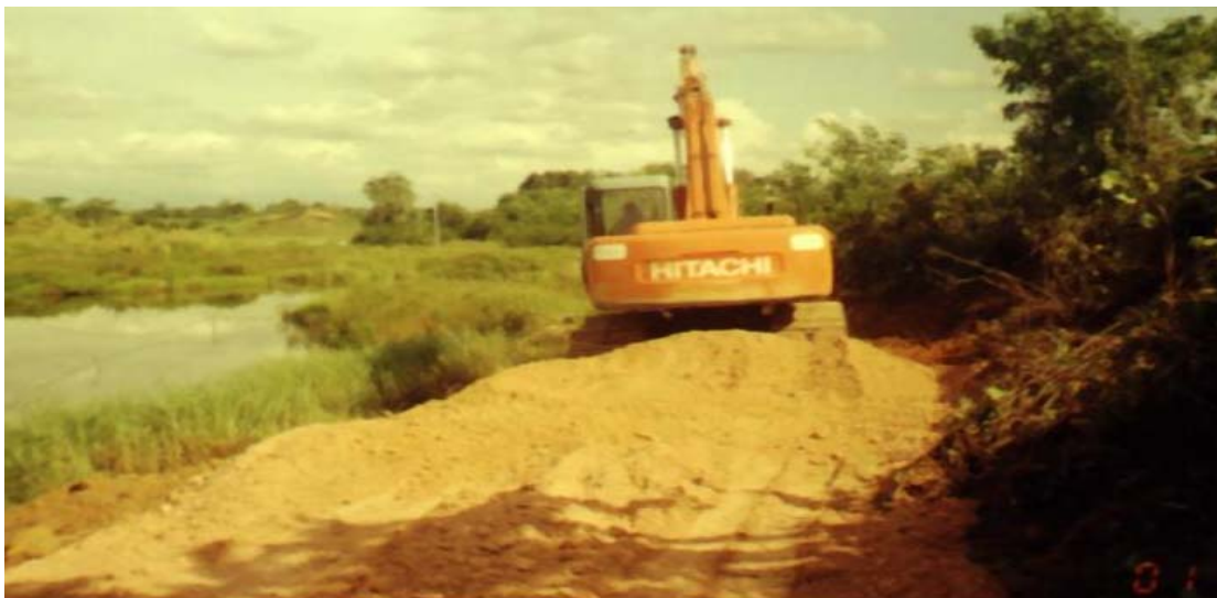
Foto 2. Adecuación de las zonas perimetrales de la ciénaga
