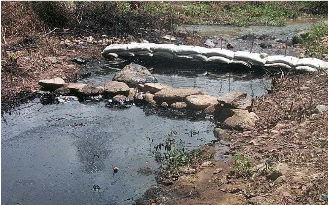
Foto 36. Barreras de contención-Sacos rellenos de arena
