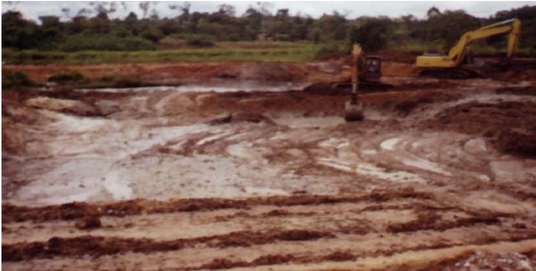
Foto 5. Extensión de lodos contaminados
