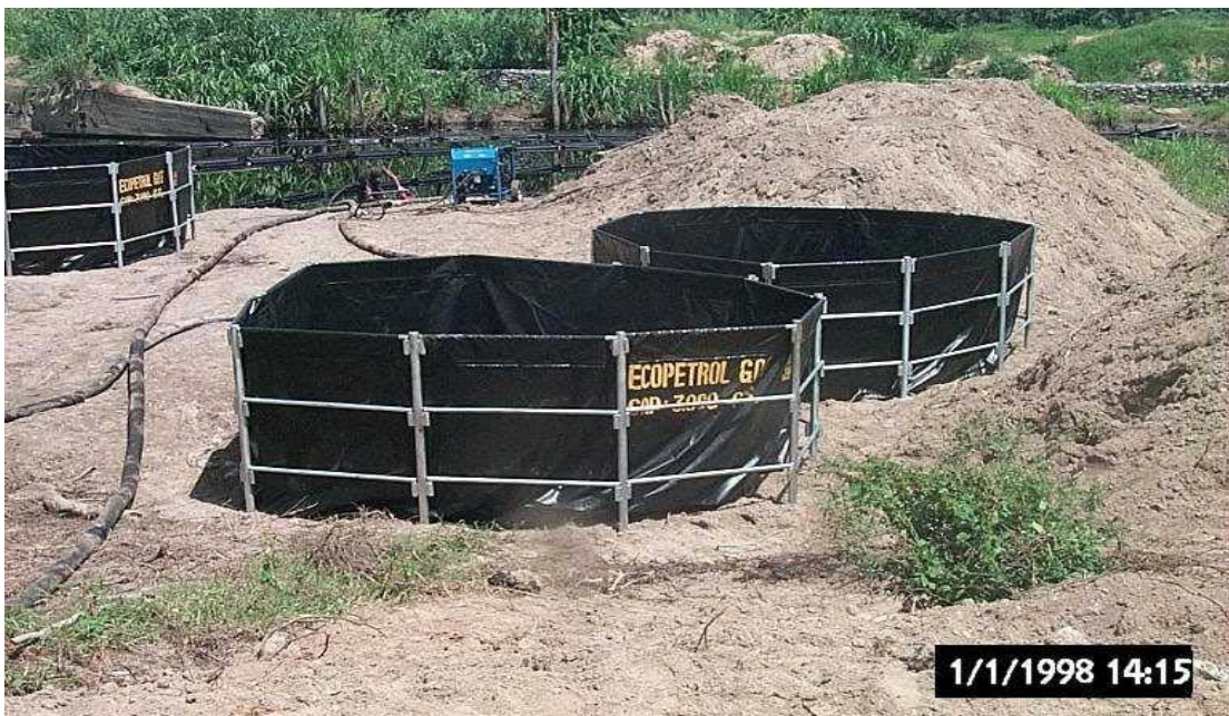
Foto 31. Uso de fast tank para almacenamiento mientras se construyen piscinas
