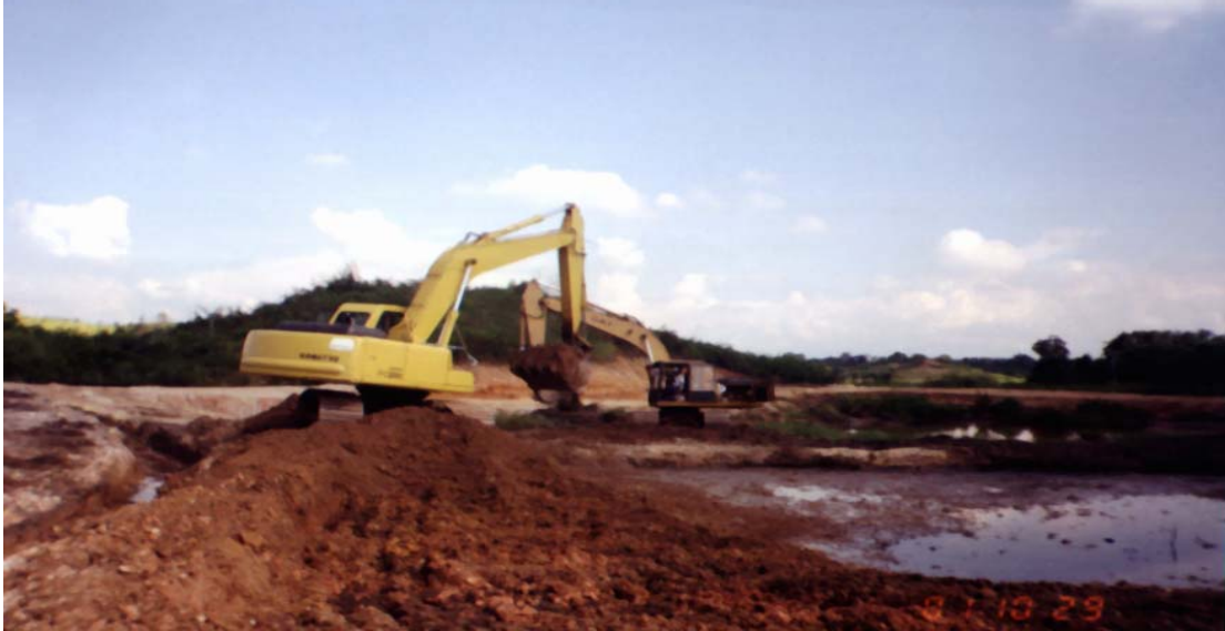
Foto 7. Construcción de diques internos para facilitar la extracción de los lodos contaminados
