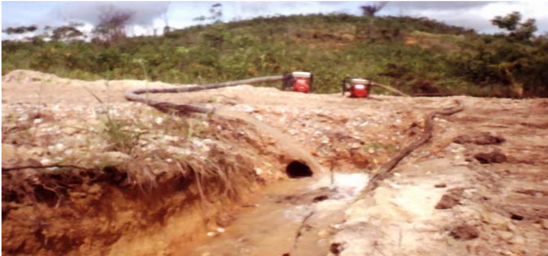
Foto 9. Drenaje de agua desde la zona a tratar hacia la otra parte de la ciénaga
