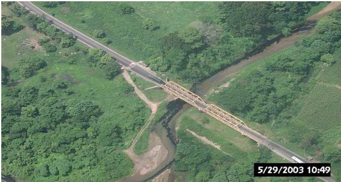
Foto 30. Carretera a la Costa Atlántica-Sitio La Mata
