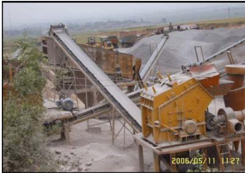
Figura 9. Planta de transporte y triturado de roca.
