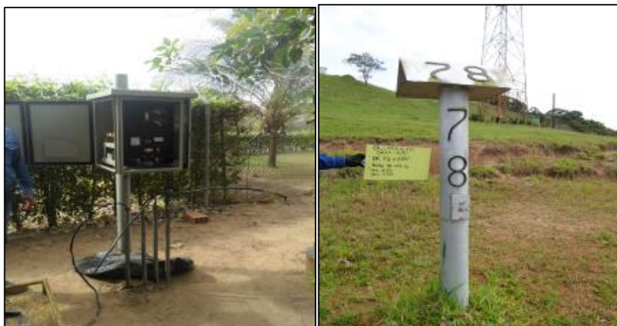
Figura 18: URPC y estaciones de prueba sistema de protección catódica oleoducto Santiago – El Porvenir
