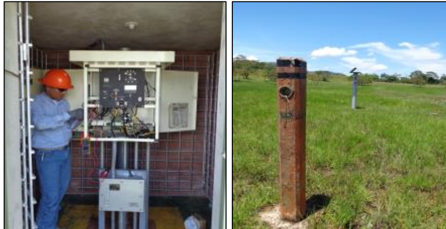
Figura 17: URPC y estaciones de prueba sistema de protección catódica oleoducto Araguaney – El Porvenir
