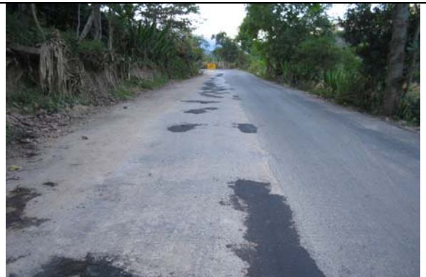
Figura No 29 Reparaciones en la abscisa K2+150.
