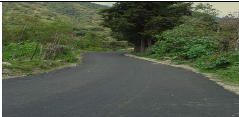
Figura No 37 Estado Final de la vía.
