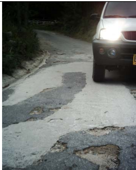
Figura No 49 Desprendimientos profundos
