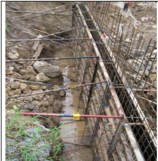
Figura No 5 Formateado del muro construido en la abscisa K21+100.
