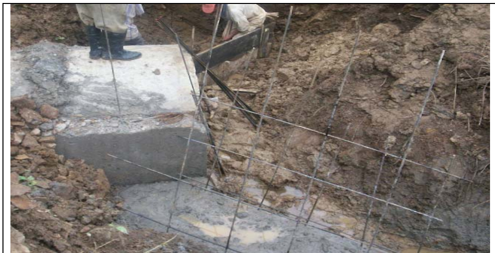
Figura No 1 Construcción alcantarilla de salida en la abscisa K28+650
