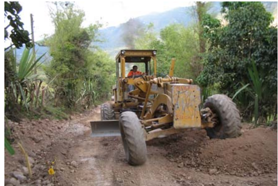
Figura No 22 Nivelación de la rasante Existente.
