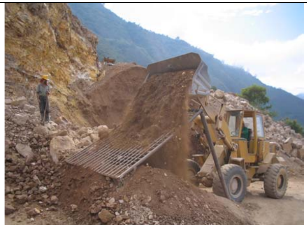
Figura No 18 Clasificación del material pétreo.
