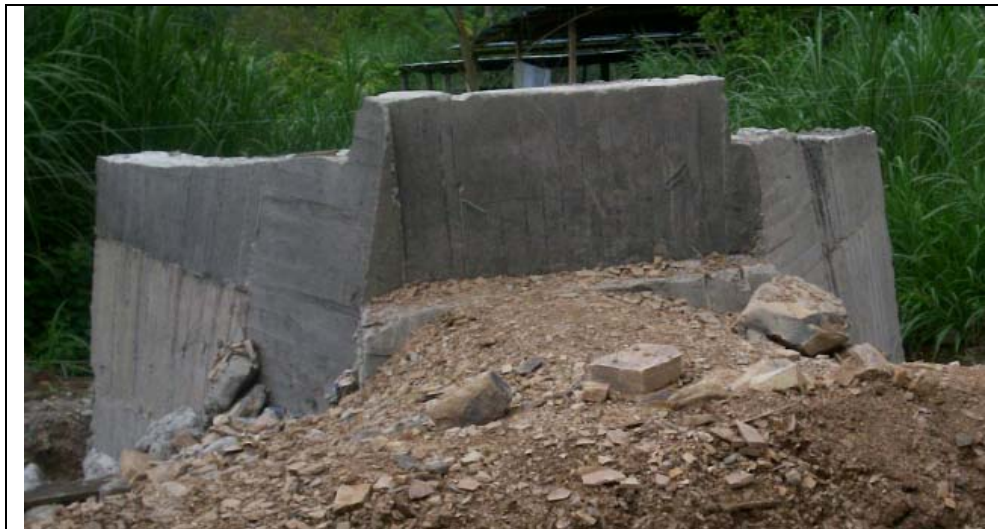
Figura No 2 Alcantarilla de salida en la abscisa K28+600
