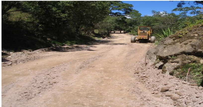
Figura No 39 Compactación uniforme de la base estabilizada.
