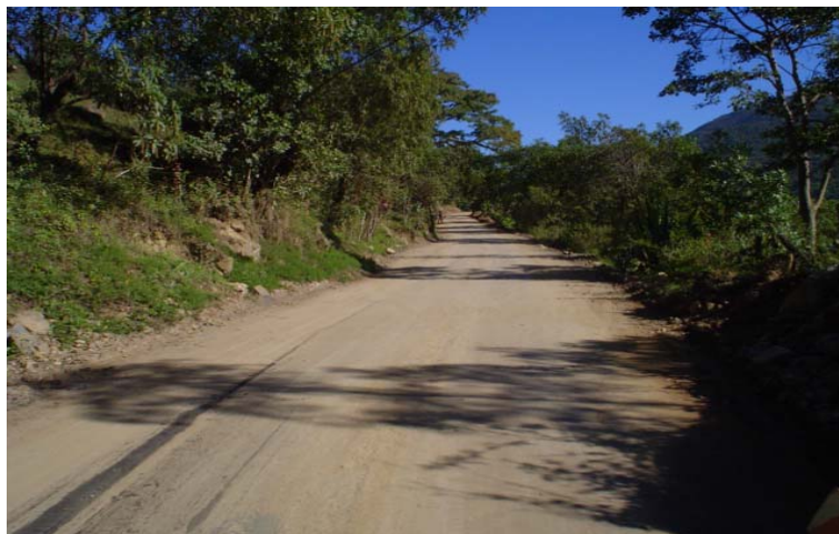
Figura No 25 Base estabilizada y compactada.
