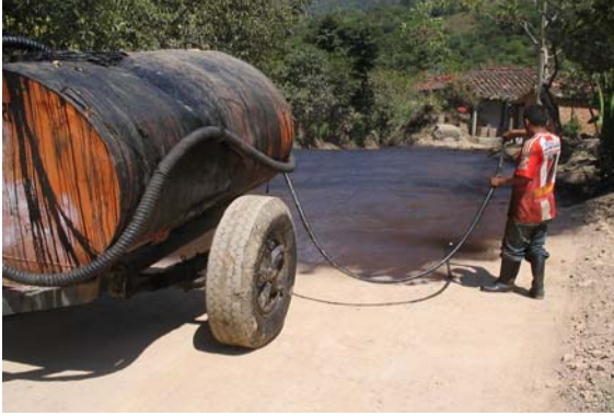
Figura No 26 Imprimación entre las abscisas K3+495 Y K3+930.
