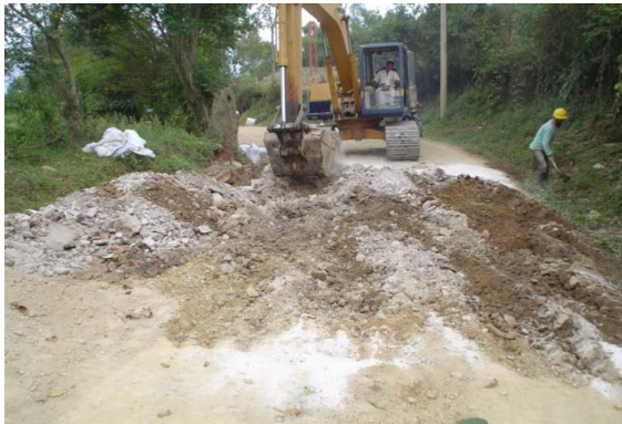
Figura No 21 Mezclado de la Cal viva con el Material de cantera.
