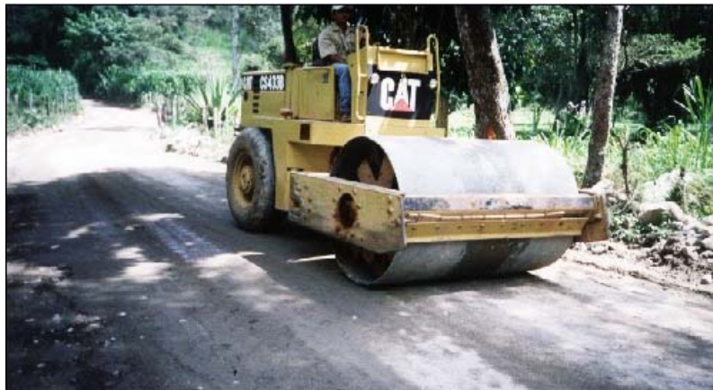
Figura No 34 Compactación de la base estabilizada.
