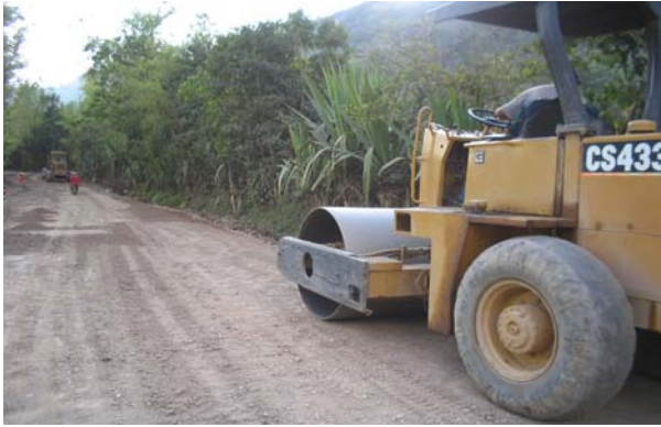
Figura No 23 Compactación del material extendido
