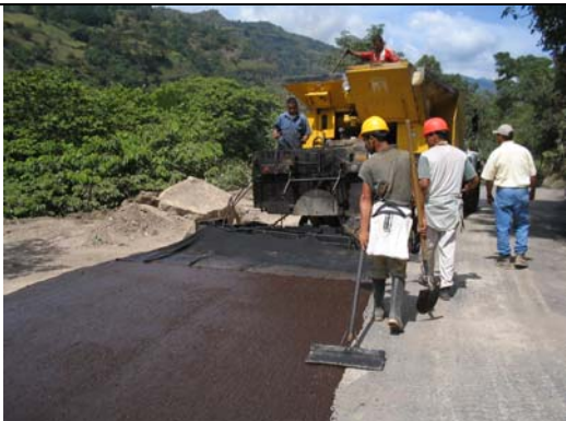
Figura No 30 Aplicación del sello asfáltico entre las abscisas K2+260 y K2+415.
