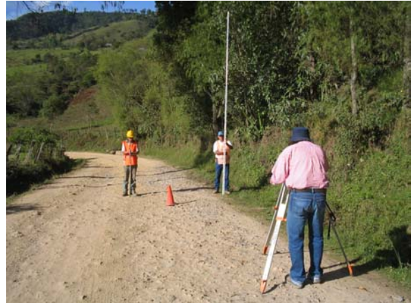
Figura No 16 Nivelación del eje y toma de secciones transversales.
