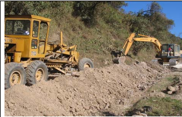
Figura No 19 estabilización de la rasante con el material seleccionado.
