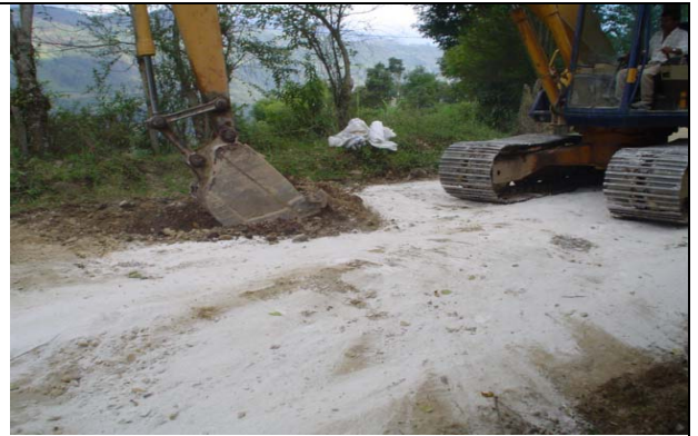
Figura No 20 Mezclado de la Cal viva.
