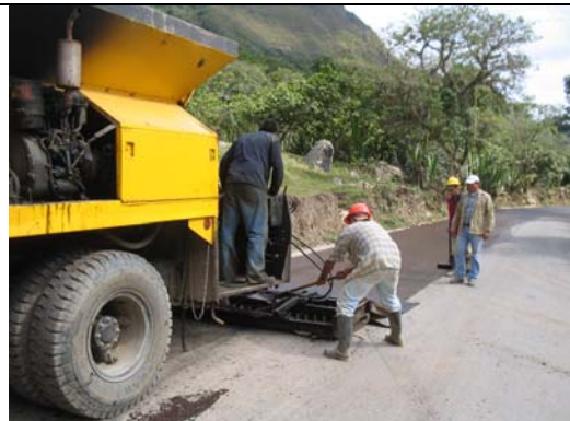
Figura No 31 Aplicación del sello entre las abscisas K2+250 y K2+530.
