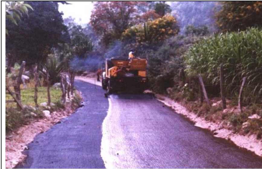
Figura No 35 Aplicación del sello asfáltico.
