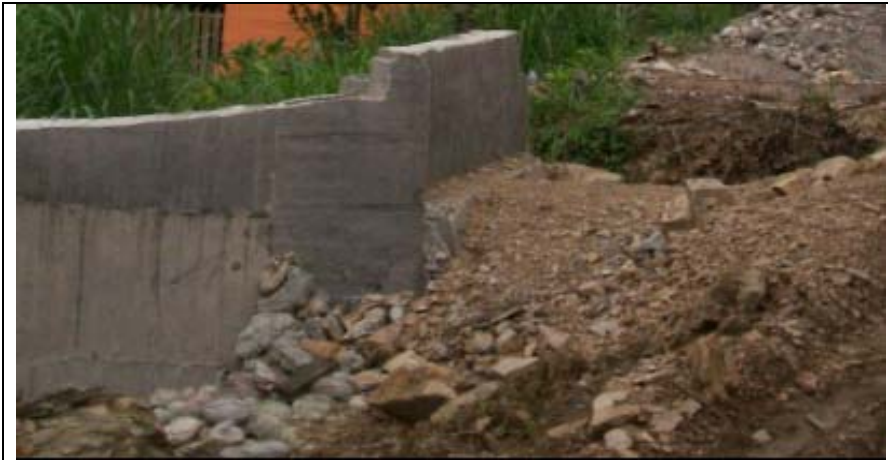
Figura No 7 Relleno estructural realizado para estabilizar en la Abscisa K28+600.
