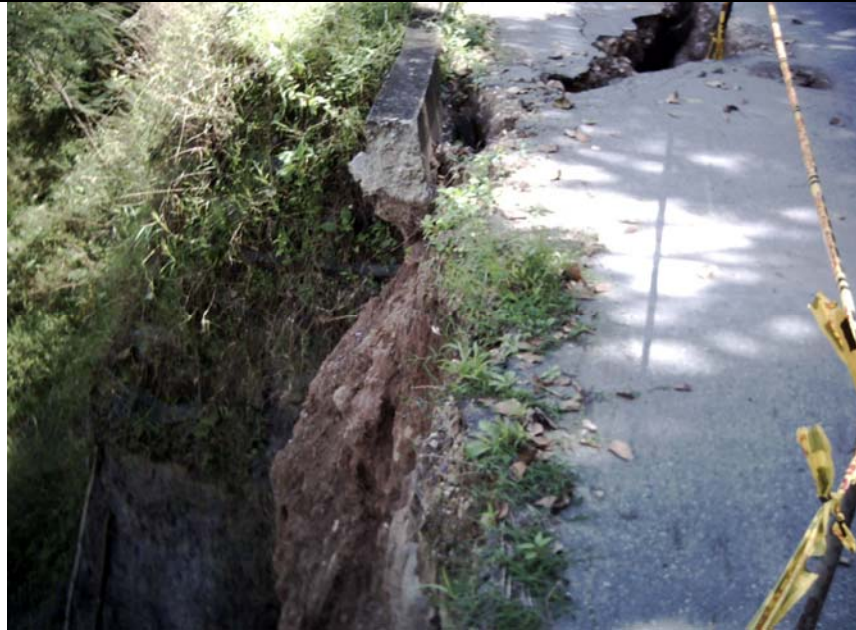
Figura No 42 Caída de la banca existente.
