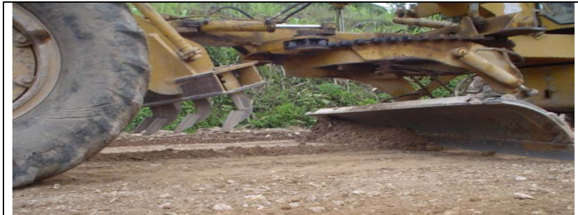
Figura No 8 Conformación de la banca existente con Motoniveladora
