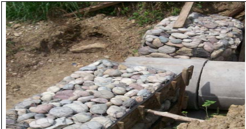
Figura No 6 Gaviones contruidos en la abscisa K28+600.
