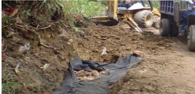
Figura No 3 Construcción del Filtro de drenaje de 50 mt.
