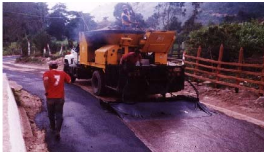
Figura No 36 Aplicación del sello asfáltico
