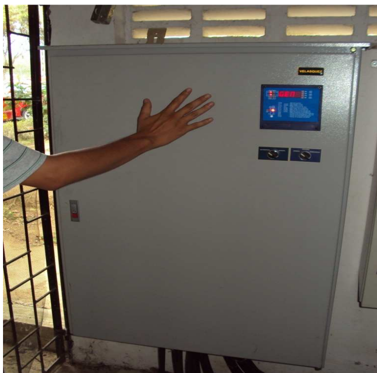
Figura 50. Celda de Transferencia Automática
