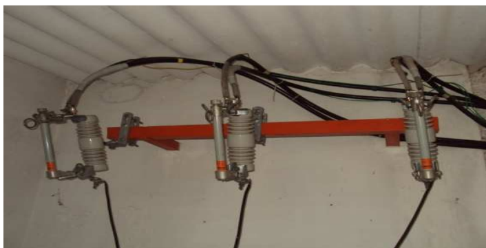
Figura 9. Cajas Cortacircuitos
