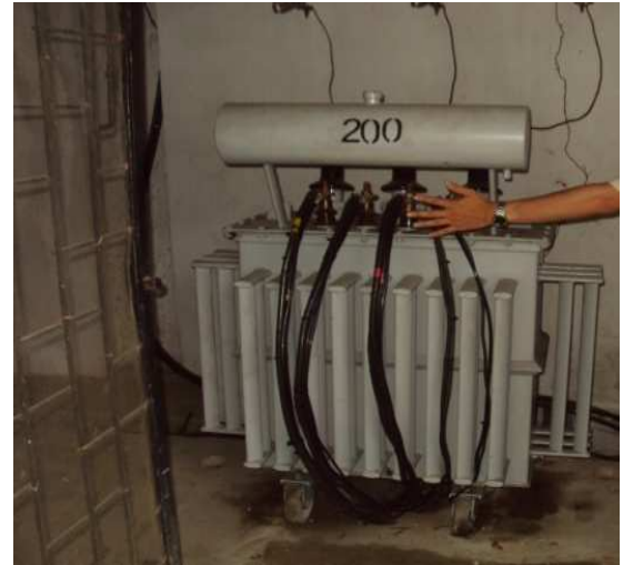
Figura 7. Transformador 200 KVA
