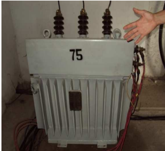
Figura 6. Transformador 75 KVA
