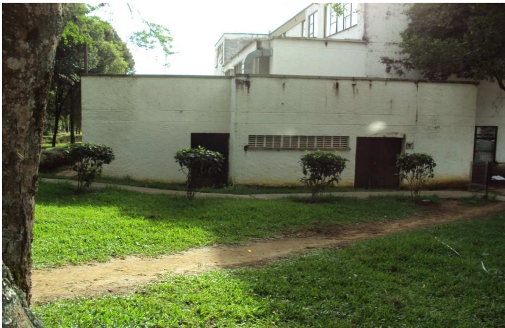
Figura 4. Fachada Subestación Administración I
