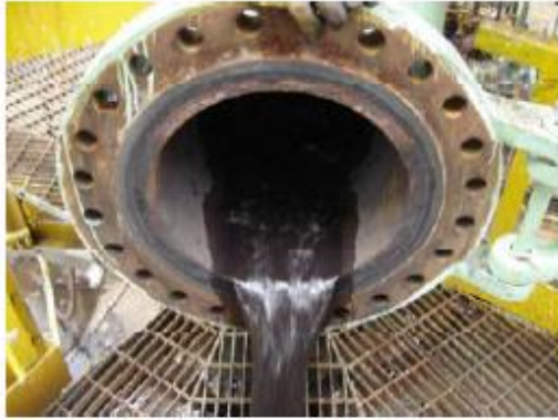
Lavado de los internos de la torre.
