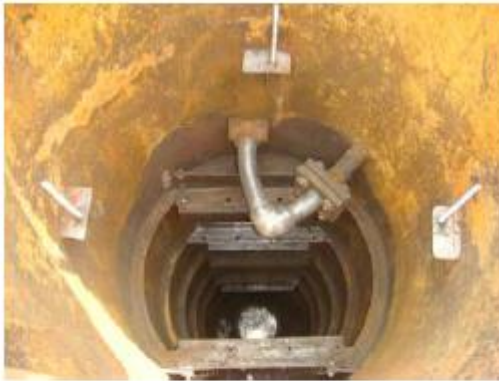
Toma superior de la torre sin platos
