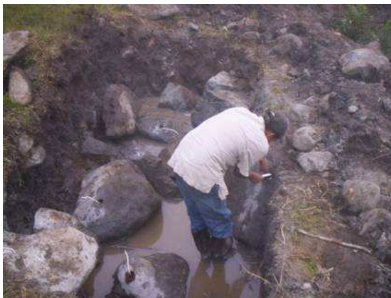
Imagen 22. Preparación de las piscinas para la sedimentación de lodos.
