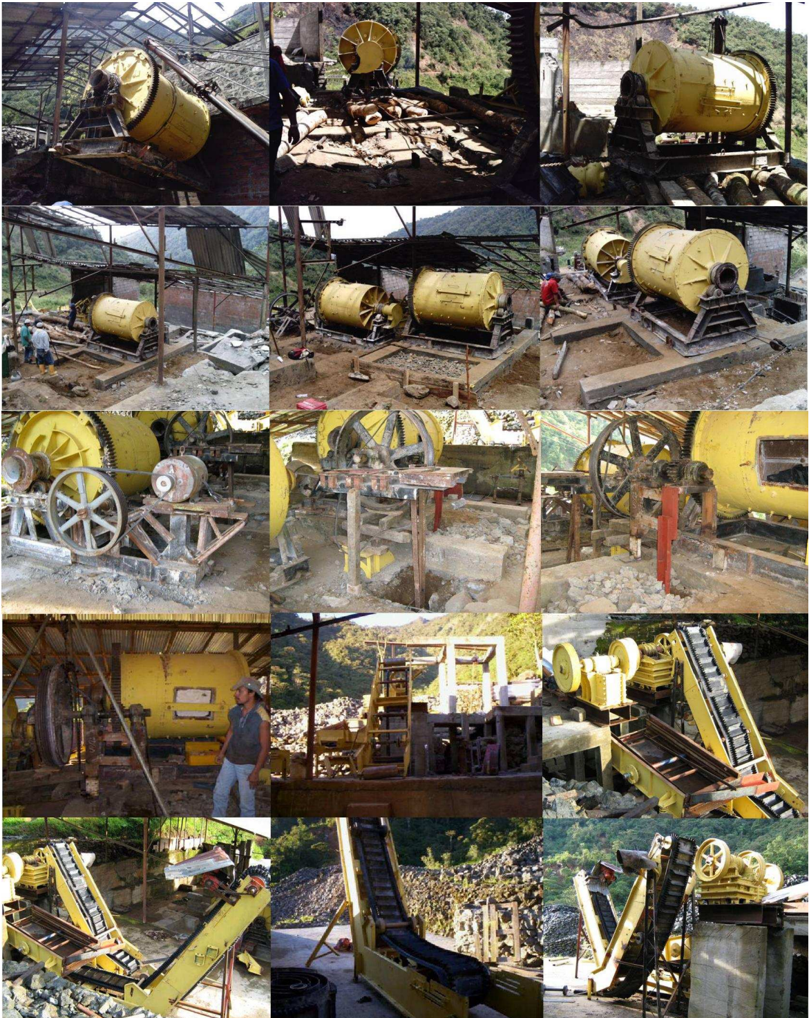
Imagen 18. Montaje de la maquinaria en la planta de Beneficio, Proyecto El Cerro
