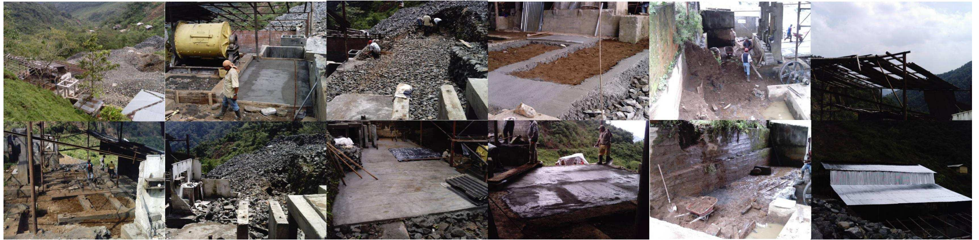
Imagen 16 Arreglos y adecuación de la planta de beneficio
