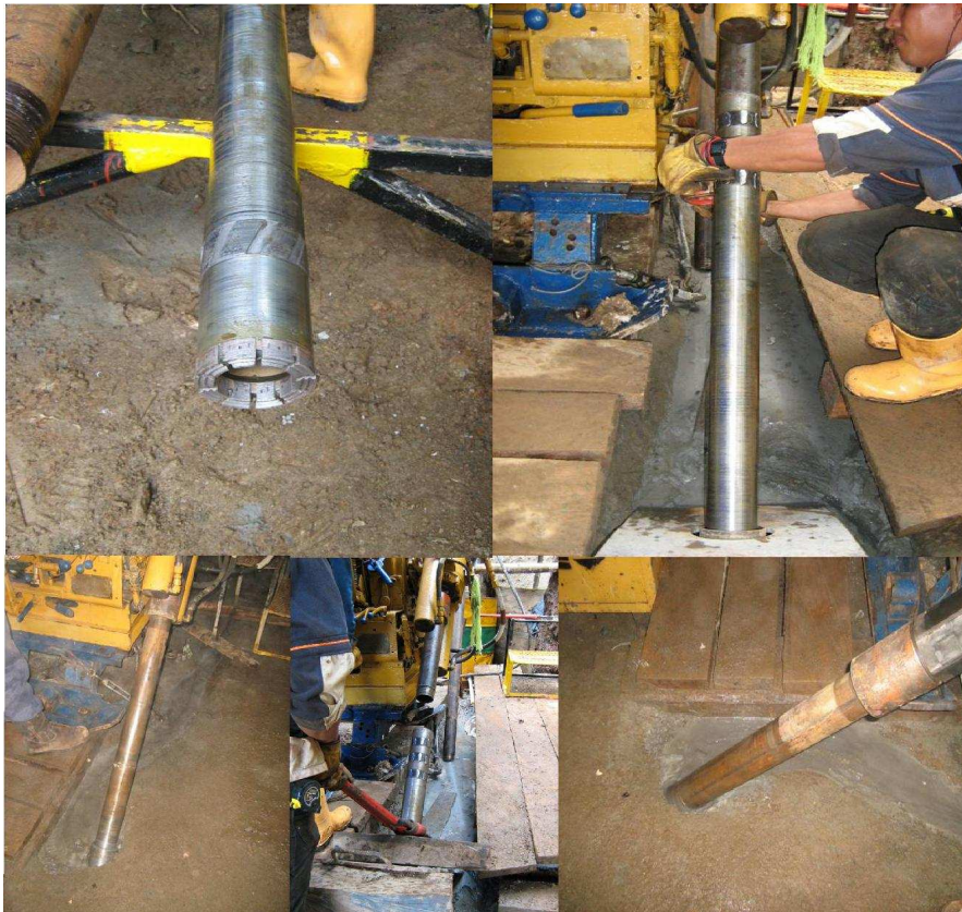
Imagen 23. Inicio de perforación en la plataforma.
