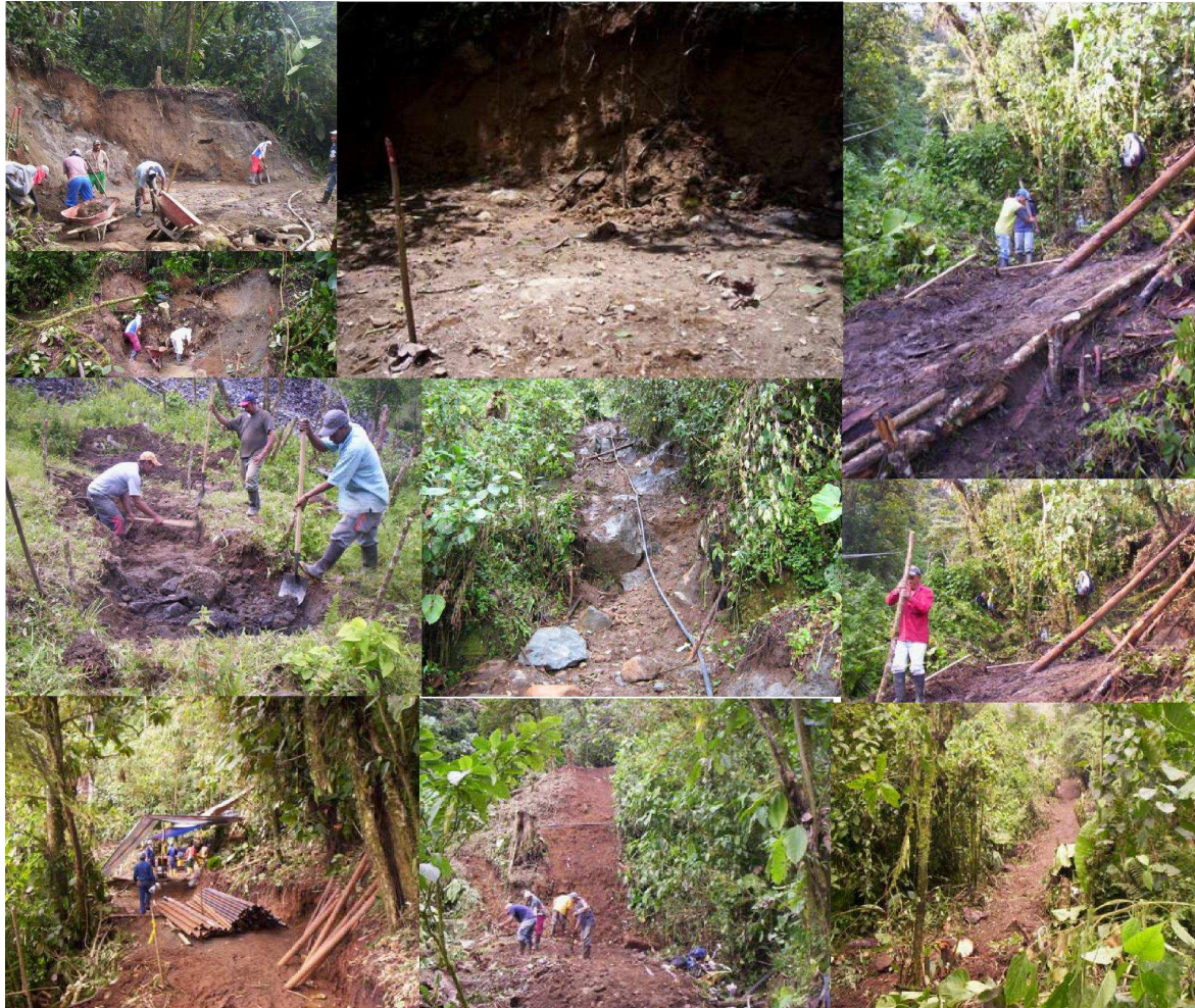
Imagen 19. Arreglos, adecuación de caminos y Plataforma de perforación
