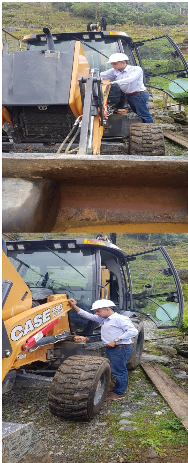
Figura 2. Mantenimiento de maquinaria
