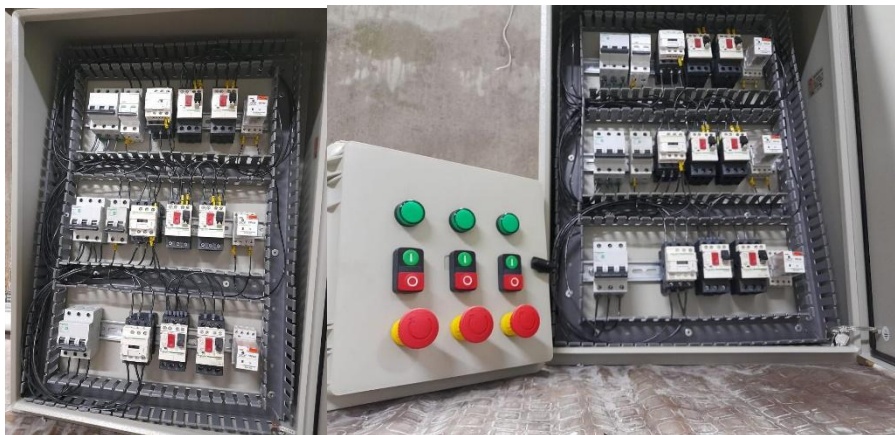
Figura 21. Implementación de modernización de Equipos
