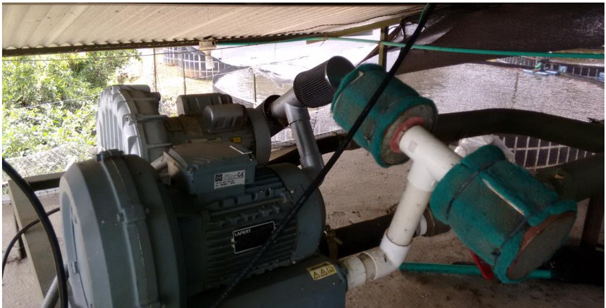
Figura A2: Montaje del equipo de aireación.
