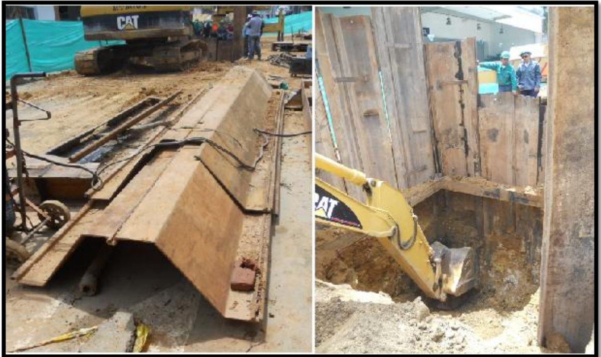
Figura 1. Tablestacado Avenida Quebrada Seca – Carrera 27 Acceso deprimido Mesón de los Búcaros.
