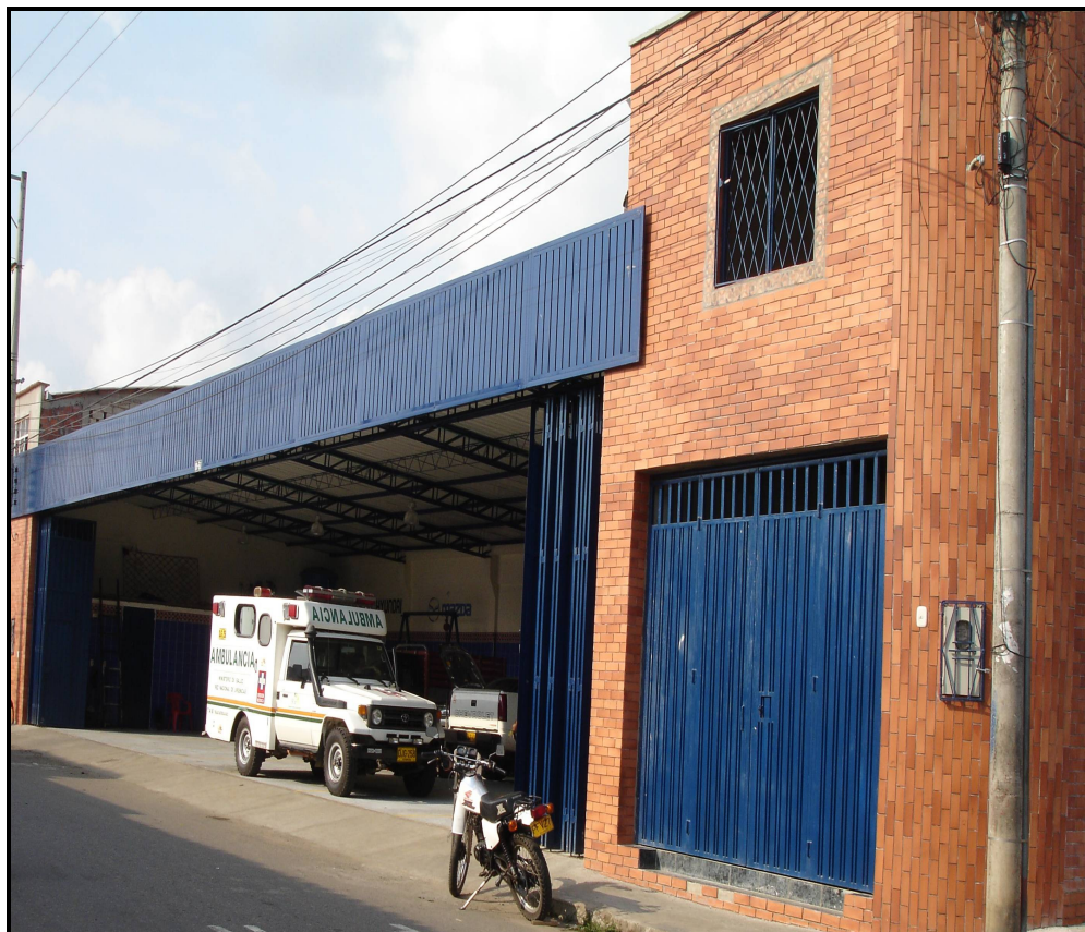
FOTO N° 2 VISTA EXTERIOR TALLER DE MANTENIMIENTO Y REPARACIÓN
