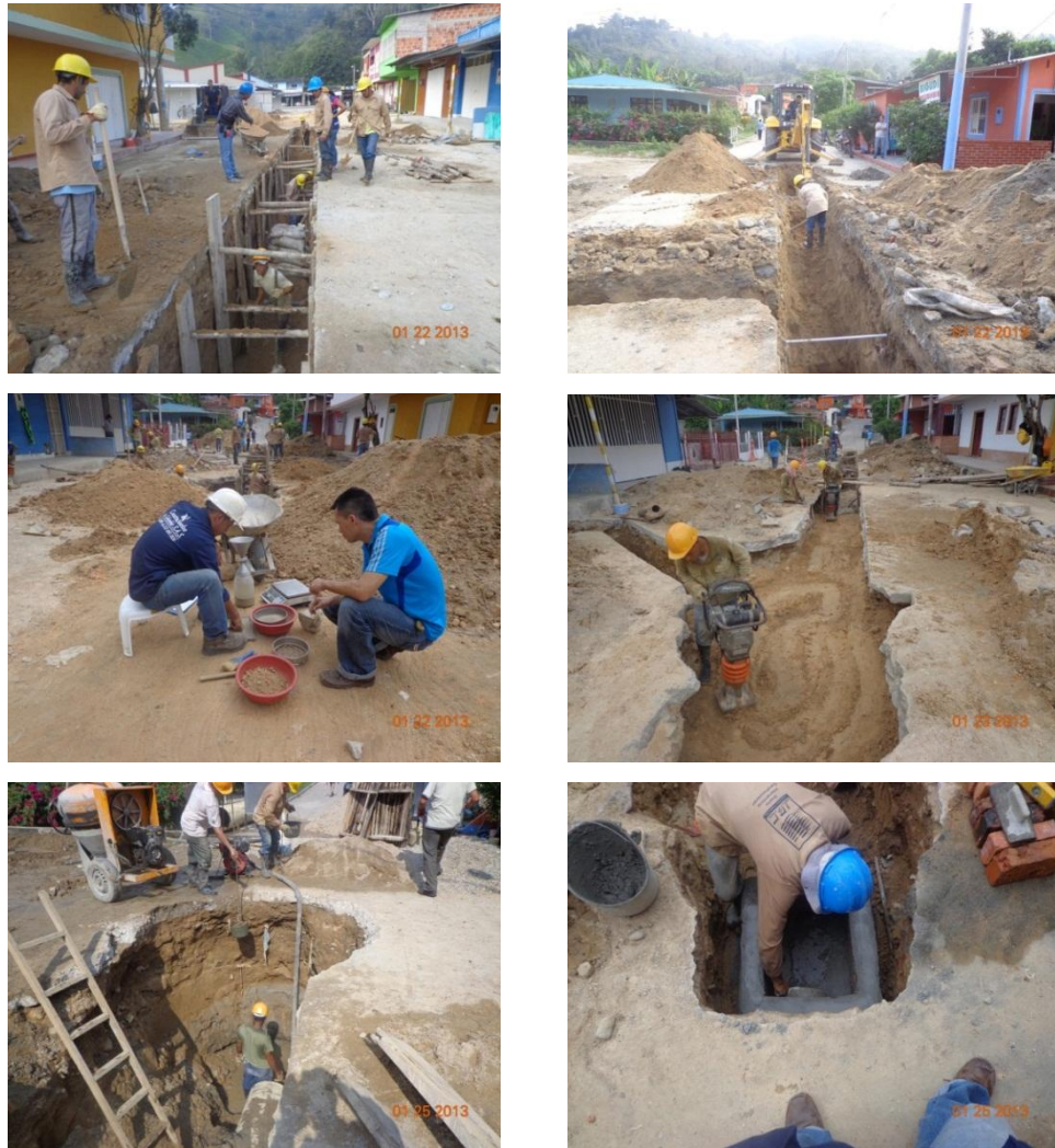
Figura 1. Obras de Alcantarillado Municipio El Playón
