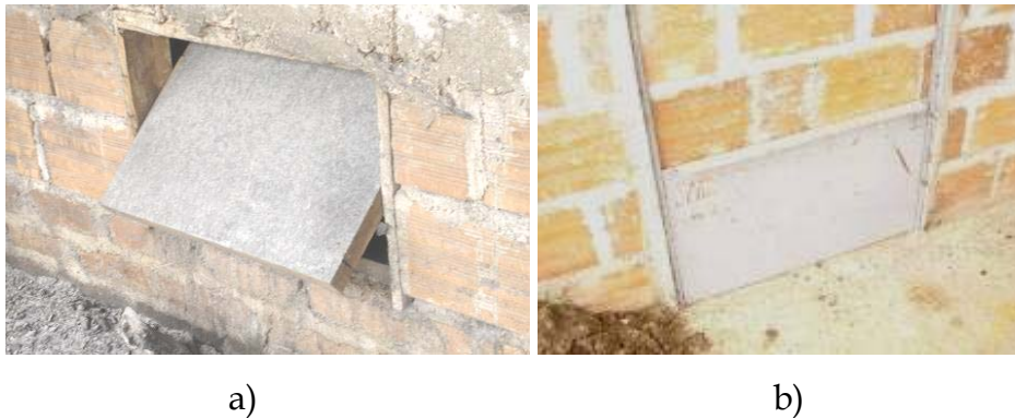
Figura 7 Ventilaciones inferiores: a) basculante; b) de corredera
