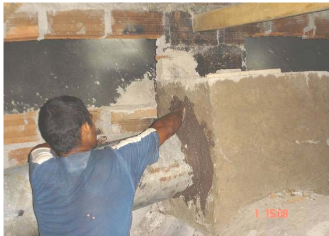
Figura 5 Sellamiento del acolpe hornilla-tubo-chimenea con masa de arcilla
