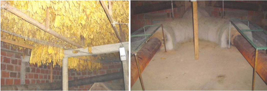
Figura 19 Mallas de protección colocadas sobre la zona caliente de los tubos de intercambio de calor
