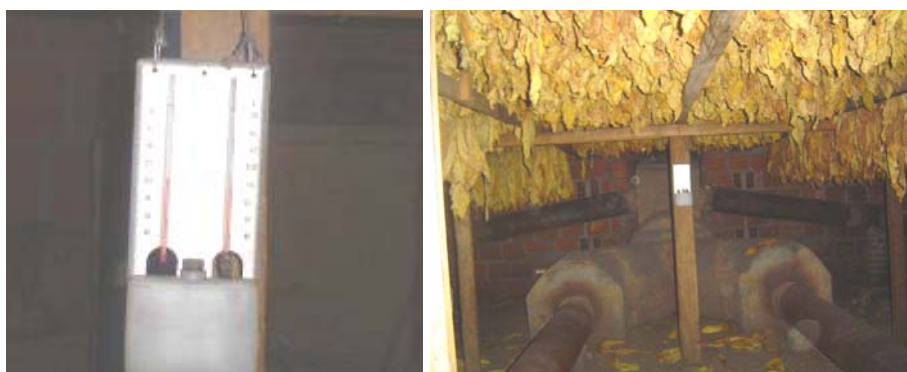
Figura 14 Sicrómetro de mecha y su ubicación en el horno
