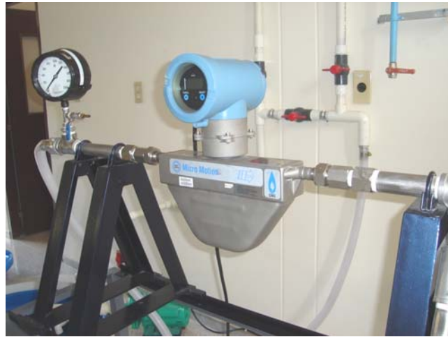
Figura 66. Montaje del medidor
