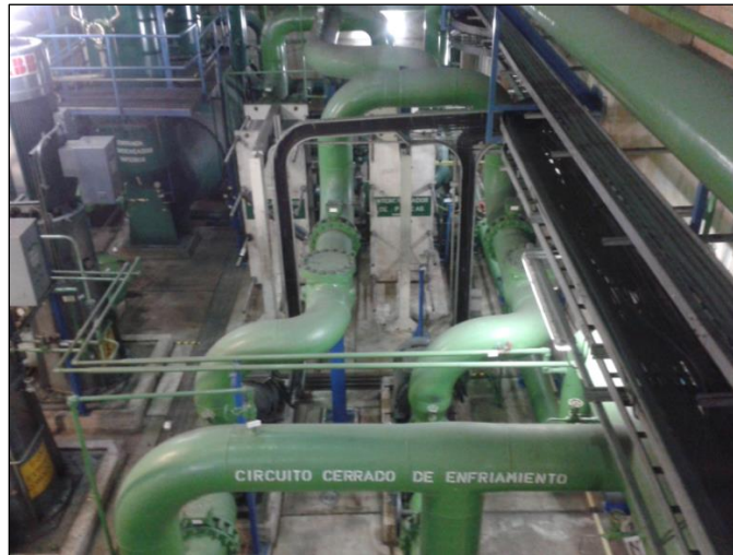
Figura J.1. Fotografía del Circuito auxiliar y cerrado de enfriamiento en C.E.S
