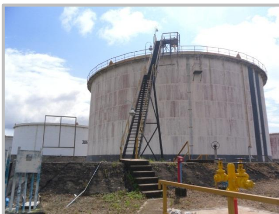
Fotografía 7. Estructuras de Acceso.
