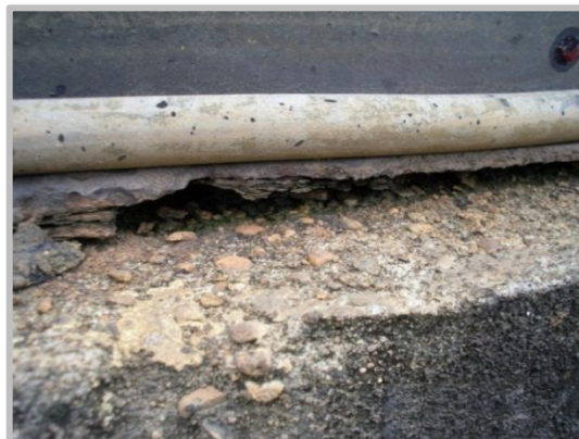
Fotografías 8 y 9: Adelgazamiento en pestaña perimetral.
