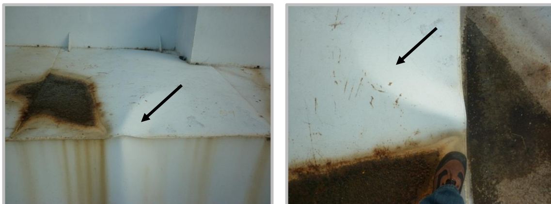
Fotografías 22 y 23: Pontón del techo flotante.
