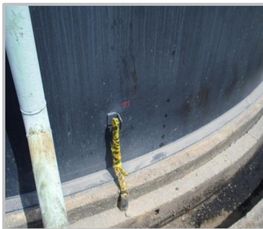
Fotografía 11: Puestas a tierra.
