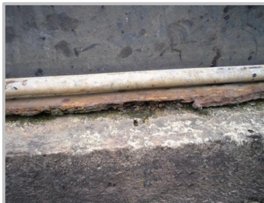
Fotografías 8 y 9: Adelgazamiento en pestaña perimetral.
