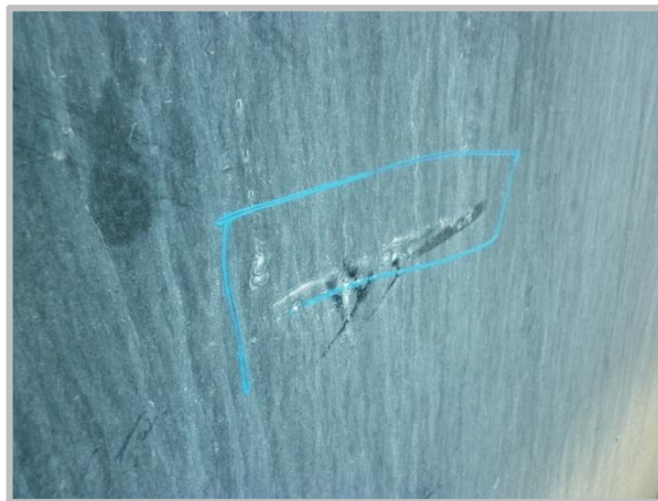
Fotografía 14: Daños Mecánicos encontrados.
