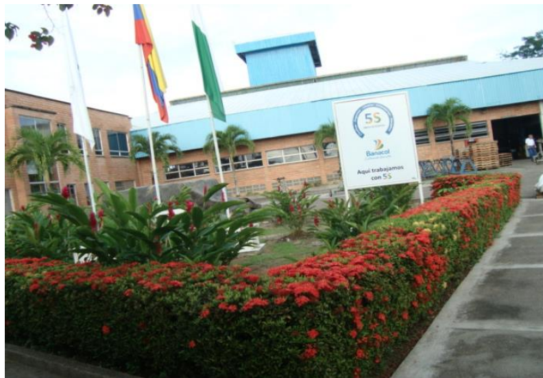
Figura 1. Fabrica de plásticos C.I. Banacol S.A.
