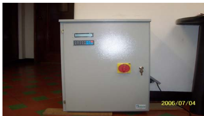
Figura 54 Vista frontal del generador
