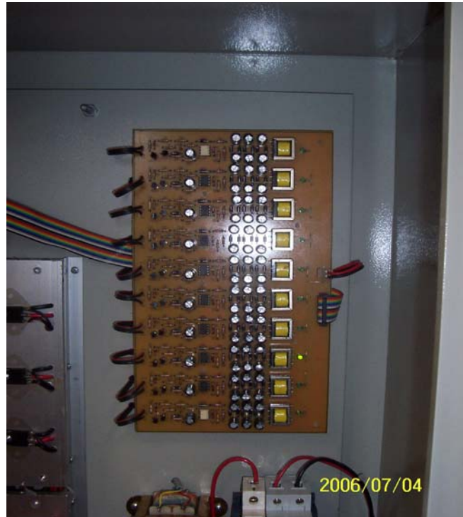
Figura 59 Configuración de la etapa de disparo
