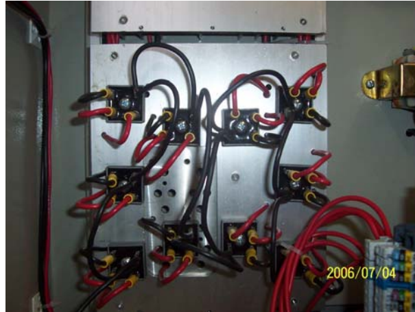
Figure 61 Distribución de los puentes rectificadores
