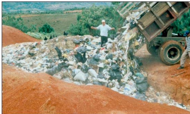
Fotografía 7. Disposición final sin compactación
