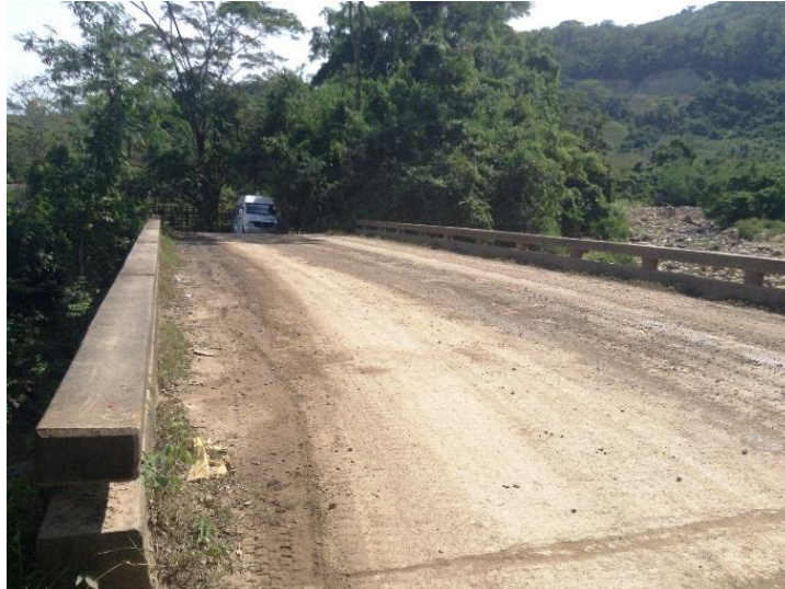
Figura 7, vista superior del tablero; Elaboración autores, 17 de Julio de 2014.
