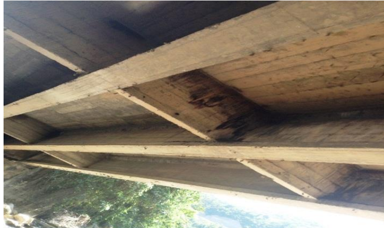
Figura 2. Tipología viga-losa, vista inferior La Parroquia; Elaboración autores, 17 de Julio de 2014.
