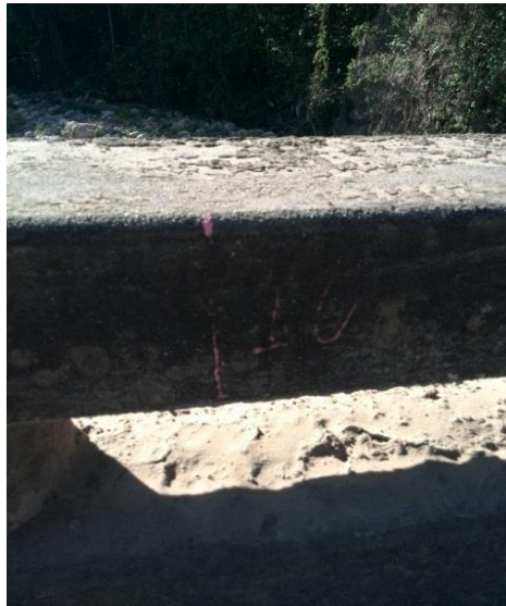
Figura 6, Acotado longitudinal de 10 metros sobre el bordillo; Elaboración autores, 17 de Julio de 2014.
