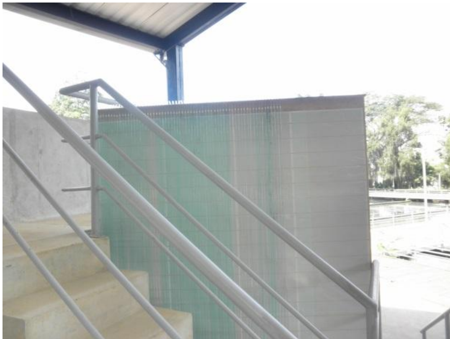
Figura 22. Fotografía, tablero de presiones
