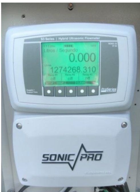
Figura 20. Fotografía, caudalímetro de ultrasonido
