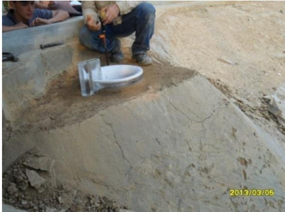
Figura 5. Fotografía, Montaje del vertedero Morning Glory
