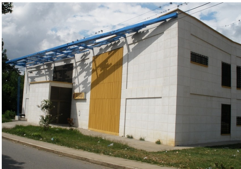
Ilustración 20 Fachada Casa de Justicia
