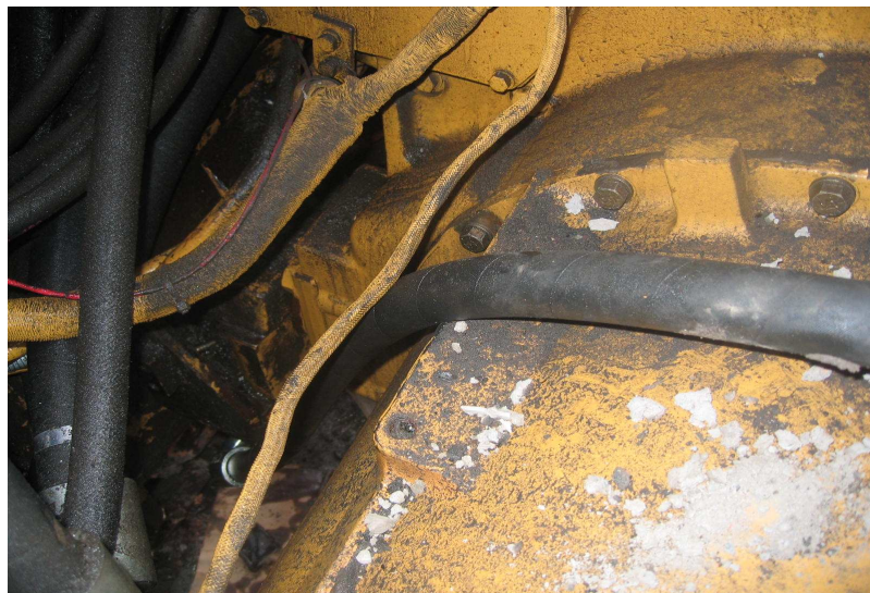
Figura 27. Las mangueras mal erutadas presentan roce con la estructura
