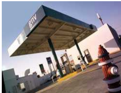
Figura 6. Estación de Servicio Llenado rápido.
