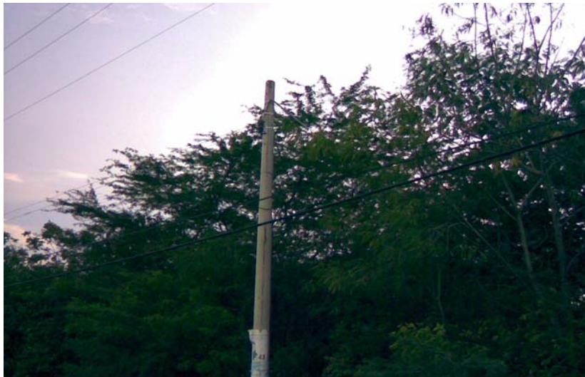
Figura 10. Hurto de una luminaria de la infraestructura de alumbrado público
