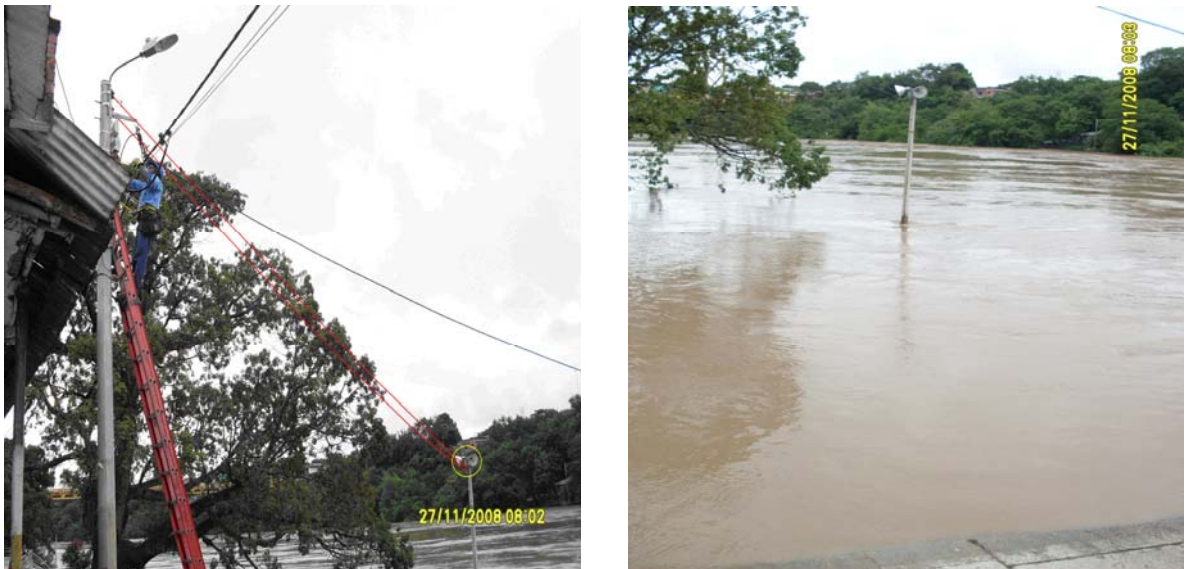
Figura 40. Atención de emergencia por inundación en alumbrado público
