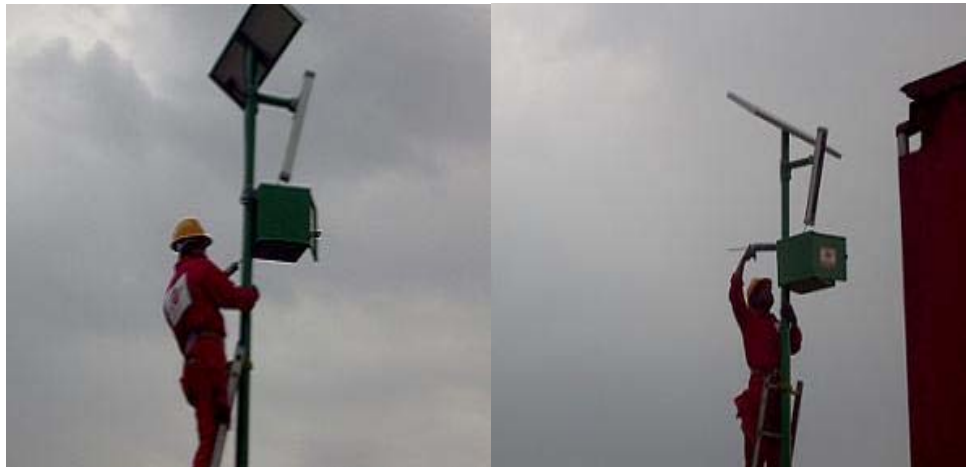
Figura 31. Instalación de luminarias con leds, alimentadas por celdas solares
