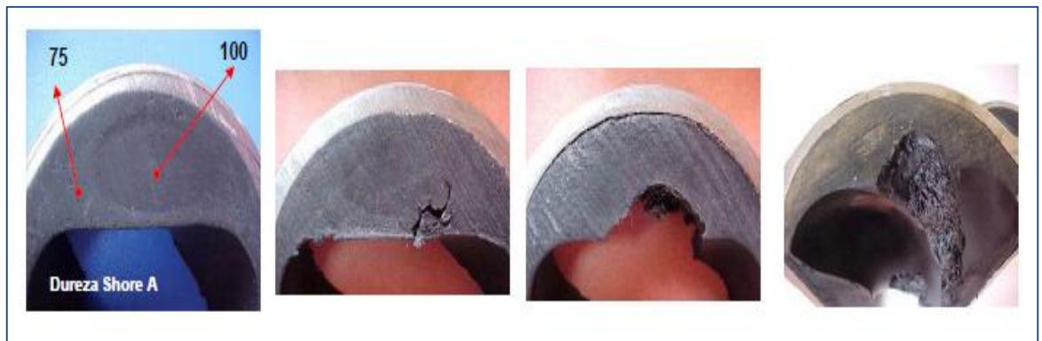
Figura 13. Secuencia de Falla.
