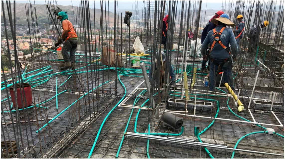
Foto 16. Revisión armado placa de entrepiso apto 1104
