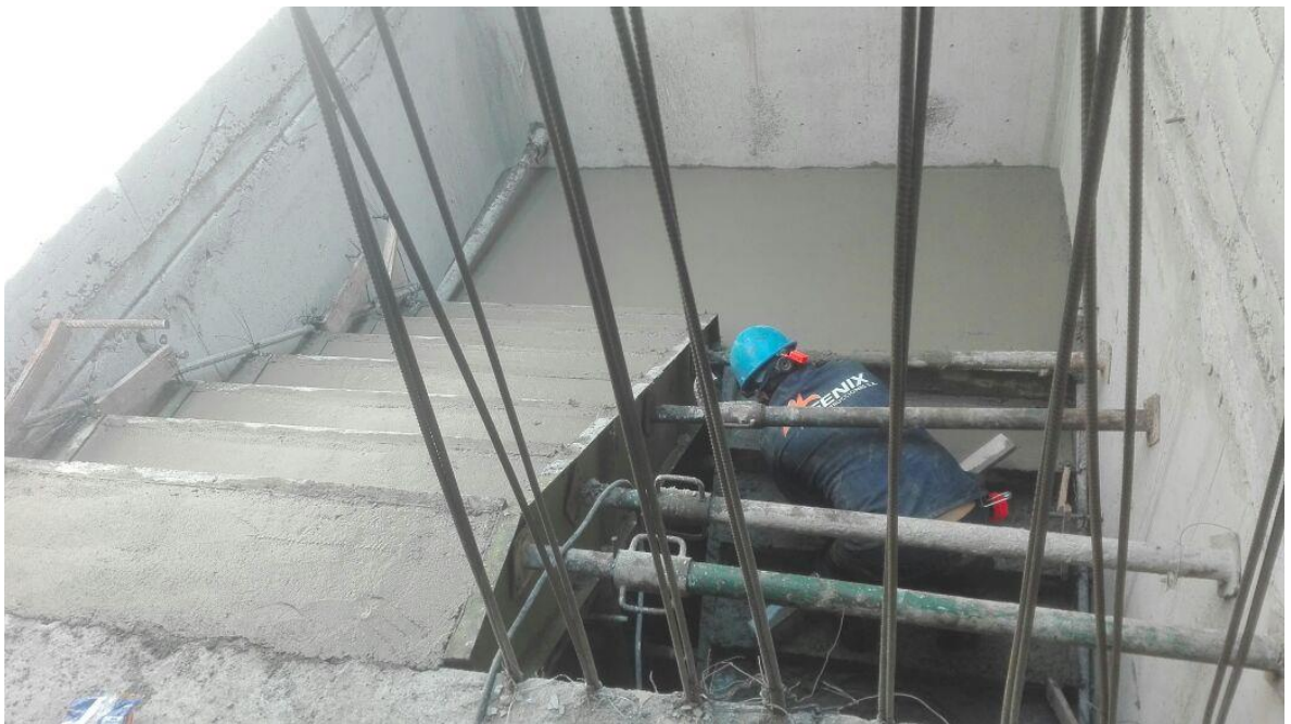
Foto 11. Fundida escalera piso 7 a piso 8.
