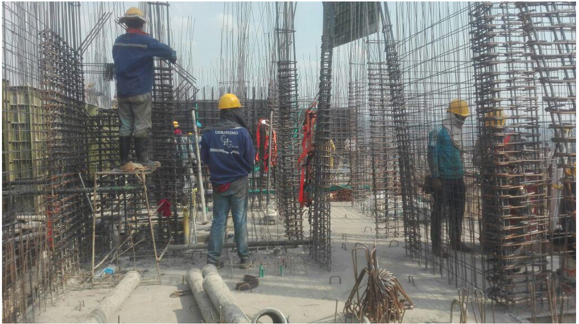
Foto 14. Revisión armado de pantallas apto 1008.
