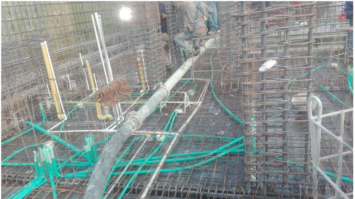
Foto 13. Revisión armada de placa apartamento 1009
