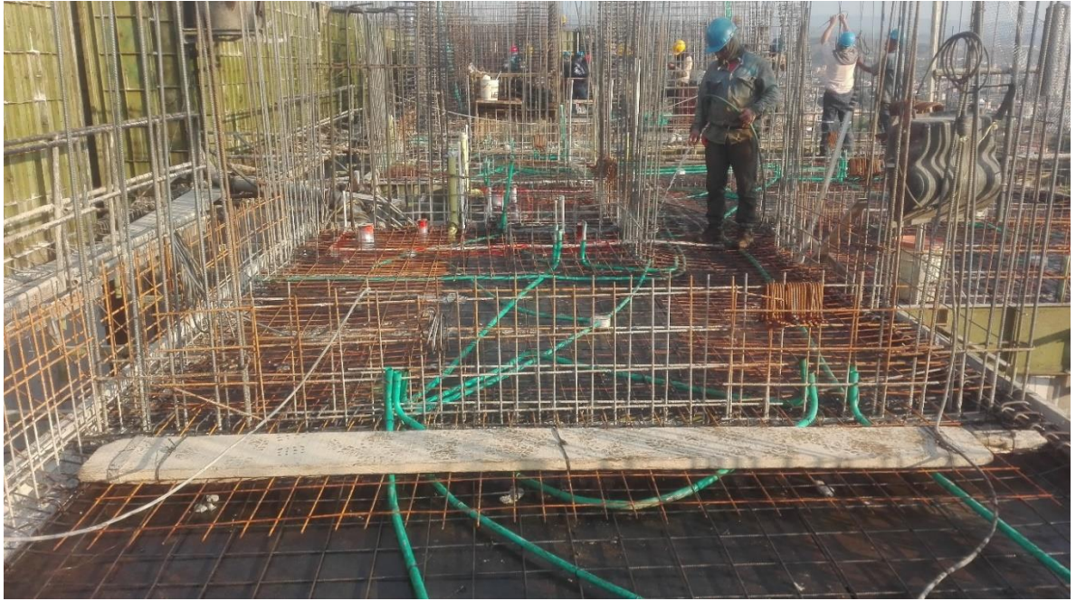
Foto 24. Seguimiento al proceso de limpieza de la placa.
