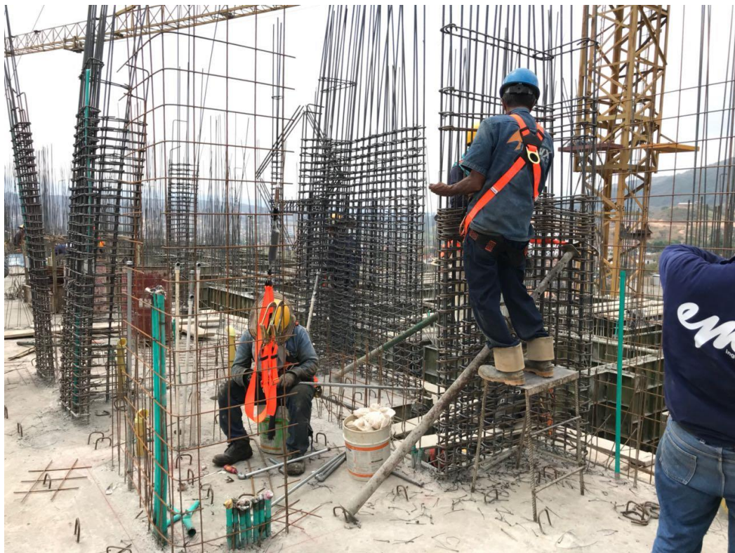
Foto 15. Armado de pantallas apto 1103.
