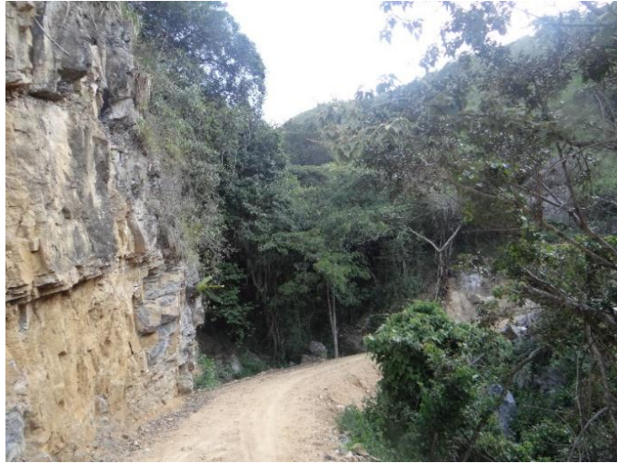
Figura 107. Adecuación de la vía terciaria en la microcuenca Quebrada Honda
