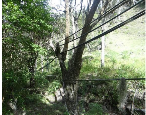
Transporte del agua por gravedad en mangueras agrícolas
