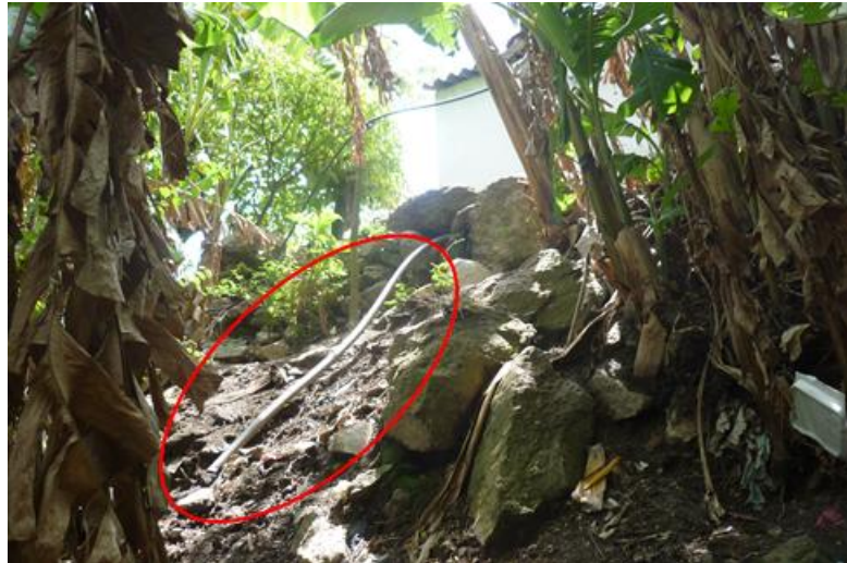
Figura 103. Disposición de aguas residuales domésticas a campo abierto vereda Peñalisa
