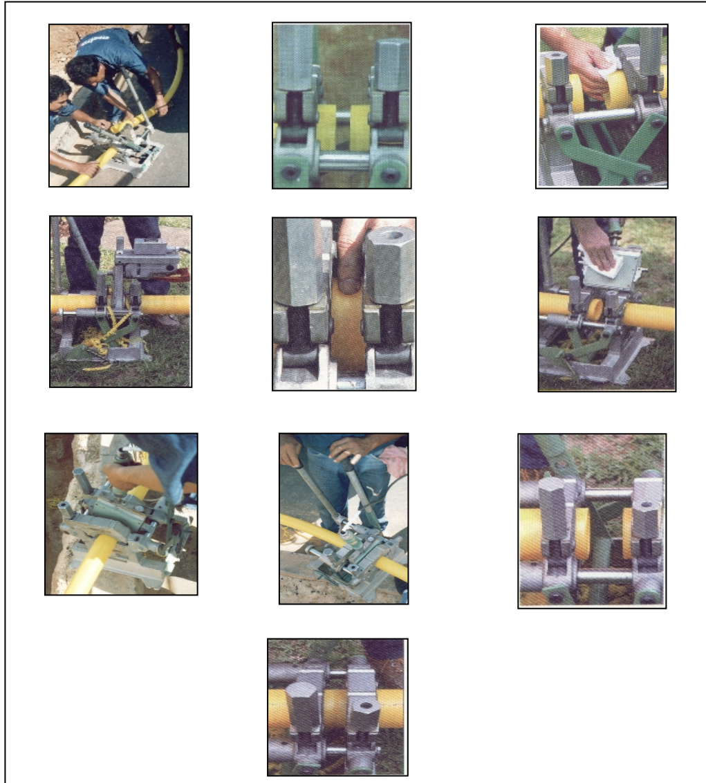
Foto 13. Procedimiento de fusión a tope
