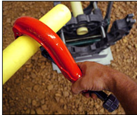
Foto 9. Corte de tubería de polietileno
