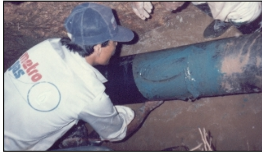
Foto 24. Revestimiento de tubería de acero
