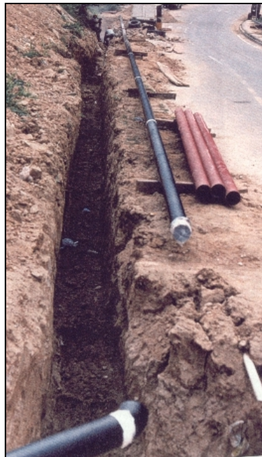
Foto 20. Montaje de la tubería de acero
