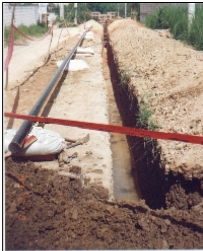
Foto 25. Instalación de tubería
