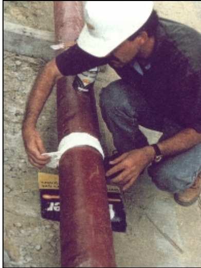
Foto 21. Protección de juntas
