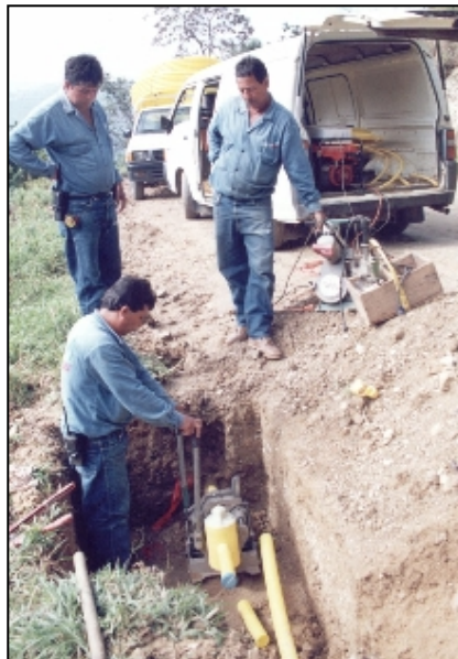
Foto 17. Instalación de poliválvula
