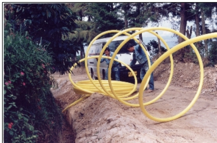
Foto 8. Tendido de tubería de polietileno
