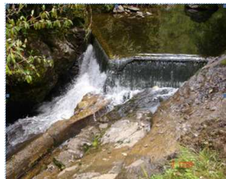
Foto No. 4 Captación la Panela
