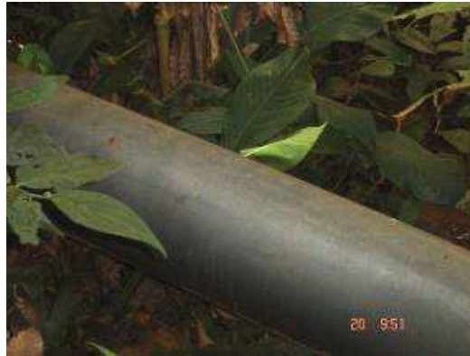
Foto No. 16 Aducción Soplavientos
