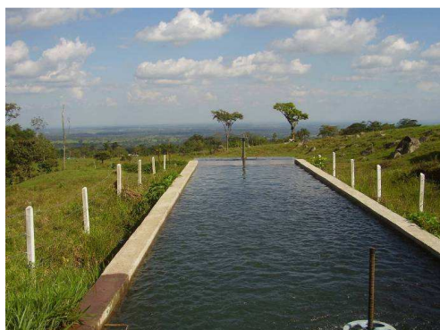
Foto No. 28 Desarenador Caney 2
