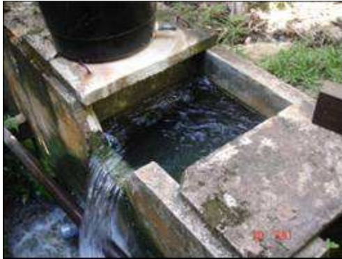
Foto No. 14 Bocatoma Soplavientos
