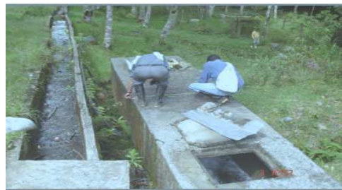
Foto No. 7 Desarenador Caño Seco
