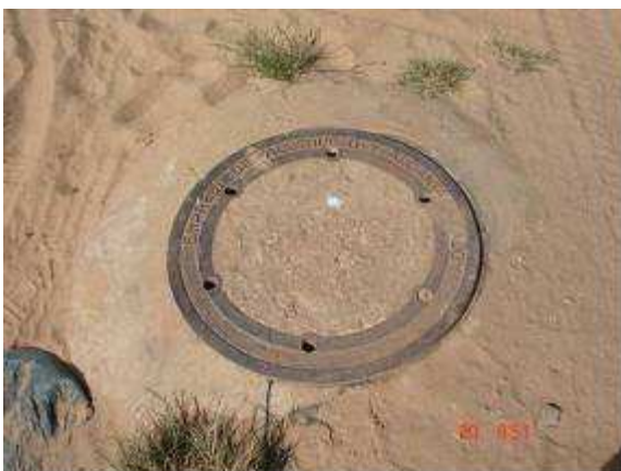
Foto No. 20 Pozo de Inspección
