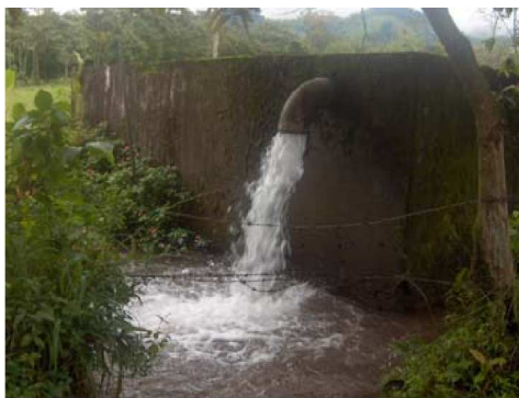
Foto No. 32 Tanque de Almacenamiento Caney 1
