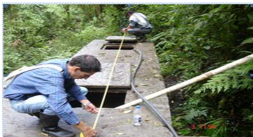
Foto No. 6 Desarenador La Panela
