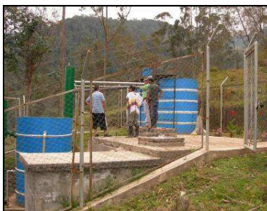
Foto No. 8 Filtro, Floculador y Sedimentador.
