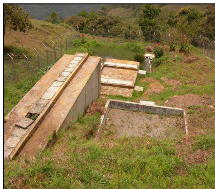
Foto No. 11 Planta de Tratamiento de aguas Residuales
