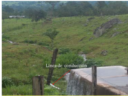
Foto No. 29 Línea de conducción Caney 1
