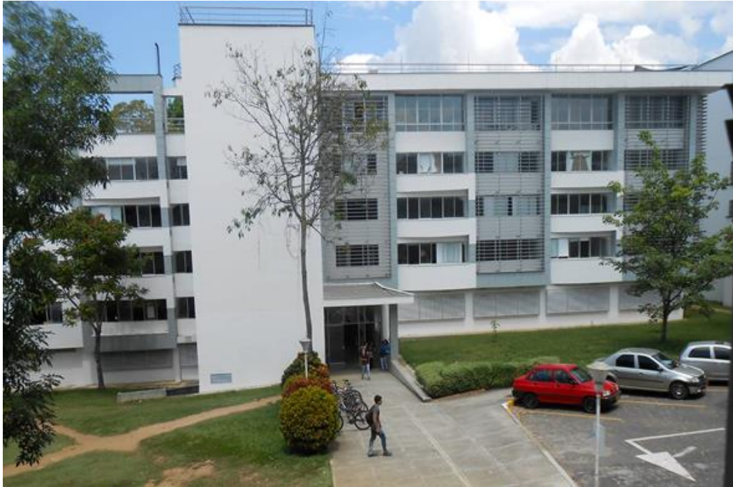
Figura 27. Vista frontal del edificio de la E3T
