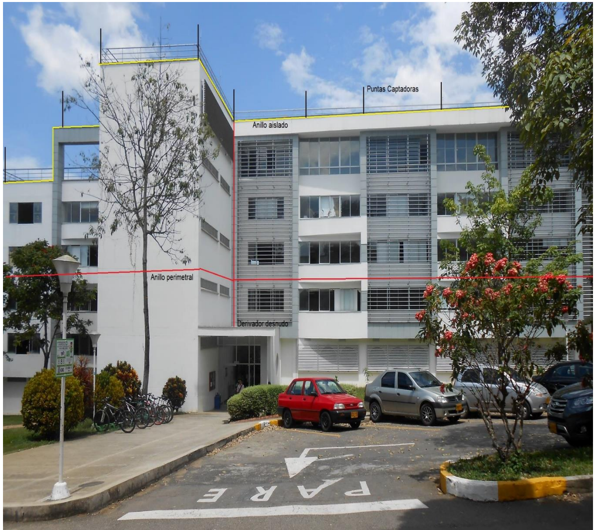
Figura 8. Vista de la protección externa contra rayos a una estructura
