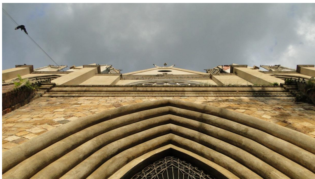
Figura 8: Vegetación en la cara externa de los muros de la fachada frontal
