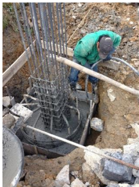
Figura 22. Concreto fundido en zapatas.
