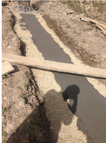
Figura 17. Concreto solado de 2500 PSI
