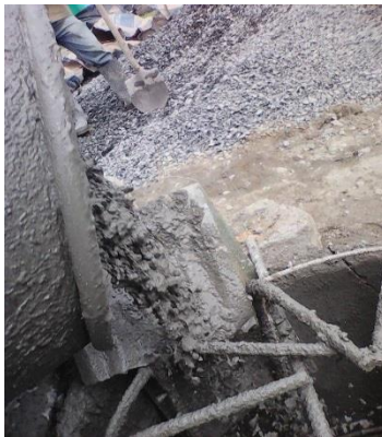
Figura 12. Fundida pilotes con concreto de 3000 PSI.
