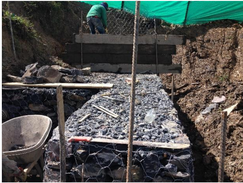
Figura 16. Muro en Gavión
