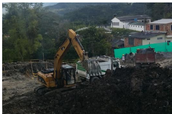
Figura 7. Movimiento de material común por Retroexcavadora CAT 320D
