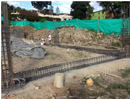
Figura 21. Armado vigas de cimentación.
