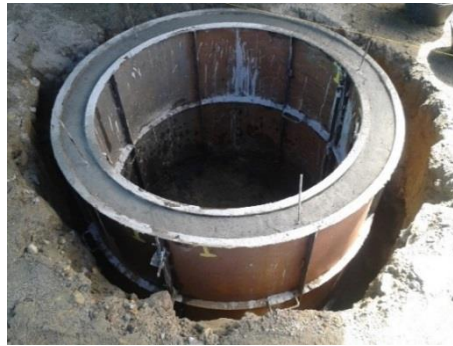
Figura 9. Anillo de protección, sistema constructivo caisson.
