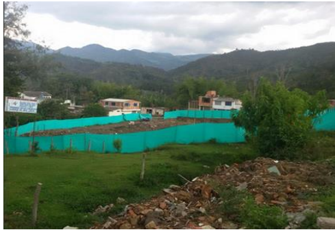
Figura 6. Cerramiento Provisional
