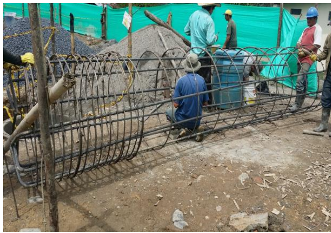
Figura 10. Acero armado para pilotes.
