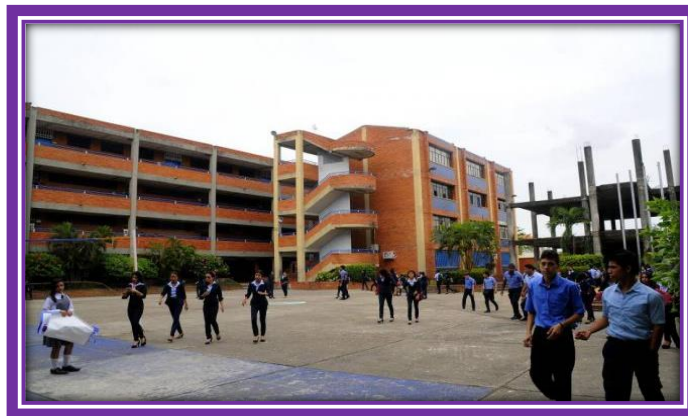
Figura 6. Vista interior del Instituto Técnico Superior de Comercio. Sede A
