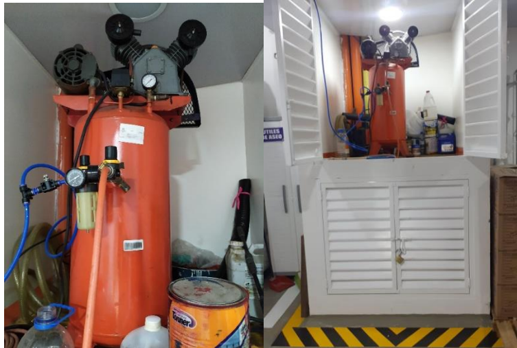
Figura 15. Compresor instalado para el funcionamiento del mototool..
