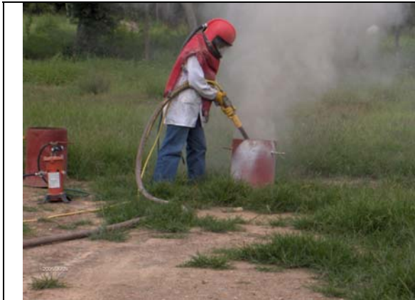
Fotografía 4. Limpieza abrasiva de la superficie metálica de los tanques mediante Sandblasting
