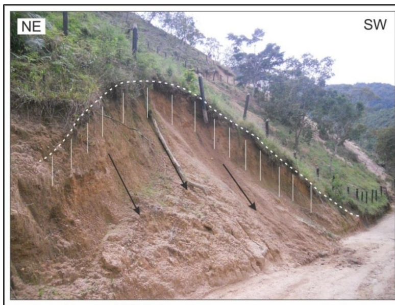
Figura 75. Deslizamiento al Este del Casco urbano.
