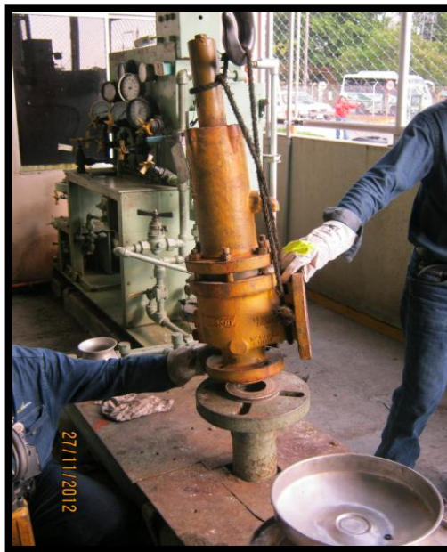
Figura 71. Instalación de válvula de alivio en banco de prueba #1 (prueba preliminar)
