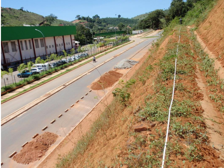
Figura 30. Talud Vial Viçosa, MG.
