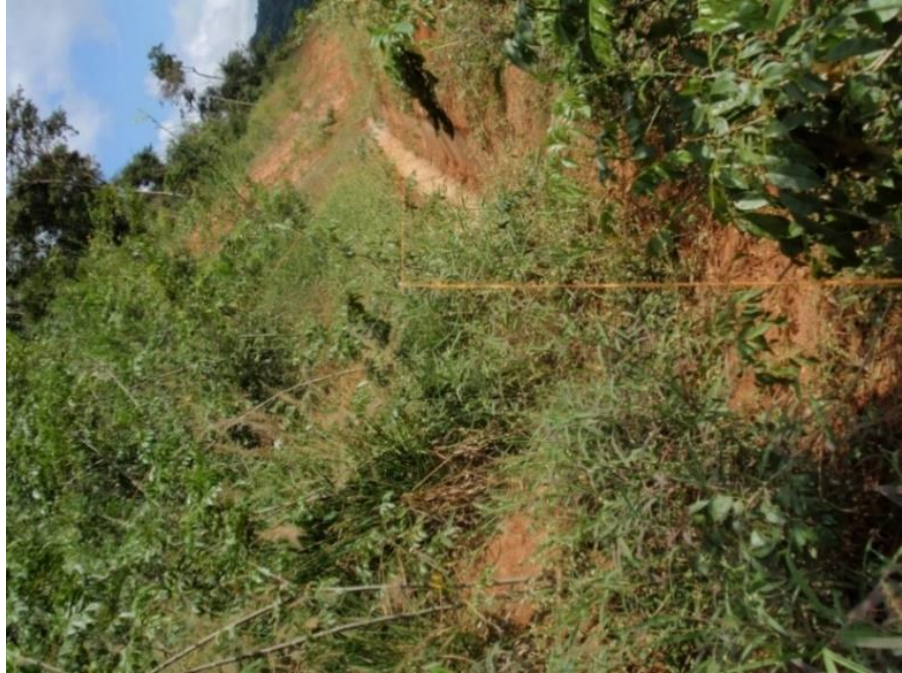
Figura 31. Instalación de parcelas Talud Viçosa, MG.
