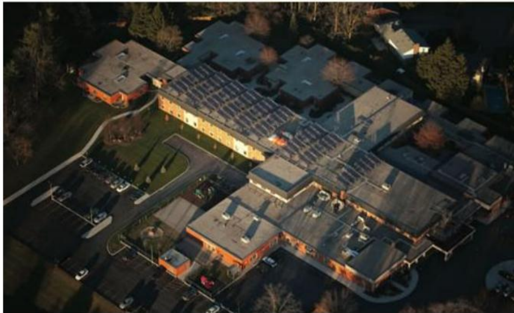
Figura 176. Instalación de refrigeración por absorción para una vivienda de la tercera edad en Canadá
