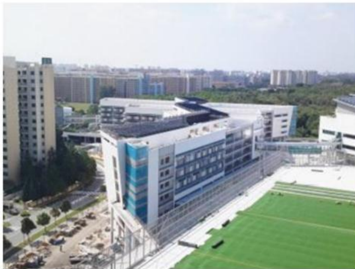
Figura 179. Tecnología solar para la climatización del colegio mundo unido (UWC) en Singapur
