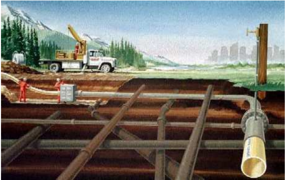
FIGURA 14. Tubería con revestimiento interno.
