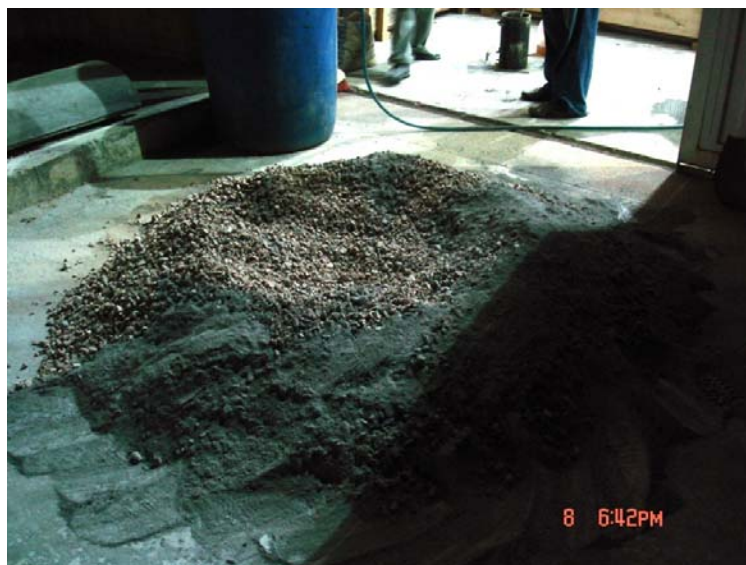
Imagen 6. Elaboración de la Mezcla.
