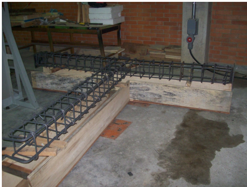
Imagen 4 Emparrillado de Acero.
