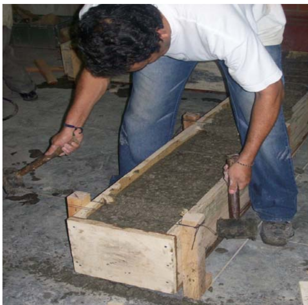
Imagen 8. Vibrado del Concreto.
