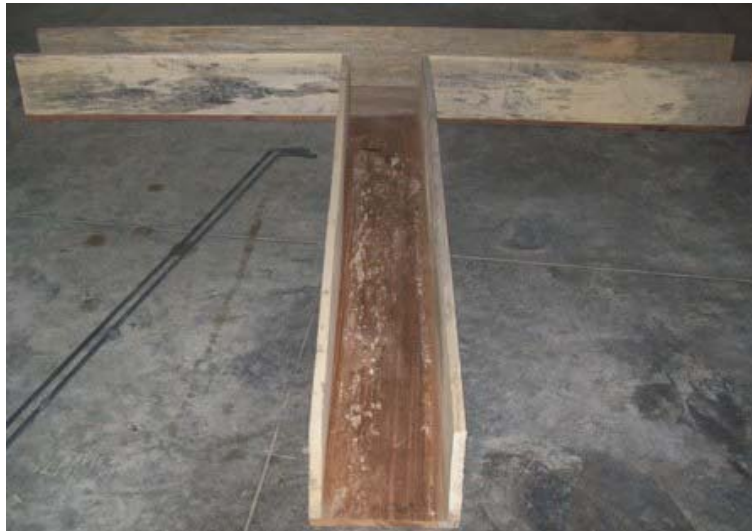
Imagen 2 Construcción de Formaleta.
