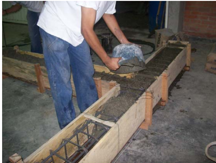
Imagen 7. Vaciado del Concreto.
