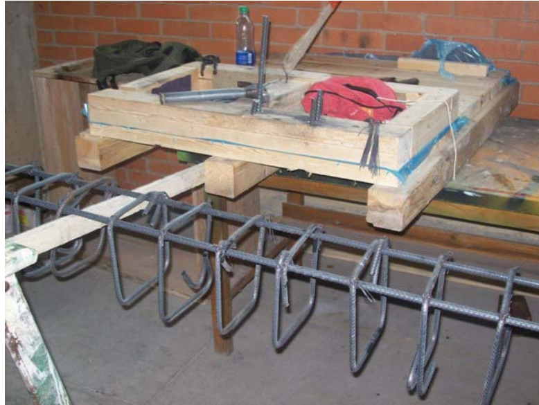
Imagen 3 Corte y Figurado del Acero.
