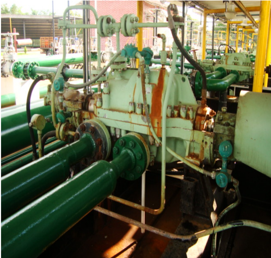
Figura 15. Bomba centrífuga Bayron Jackson PIA5
